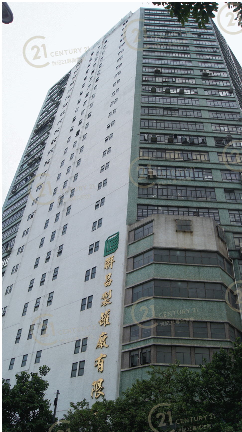
聯昌中心 Luen Cheong Can Centre
