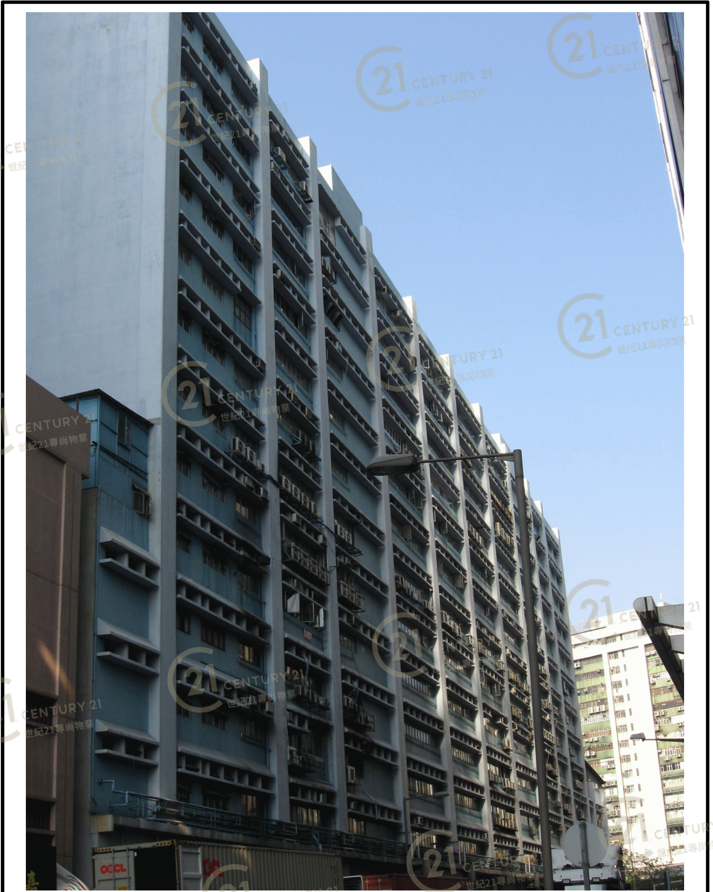
葵順工業中心 Kwai Shun Industrial Centre
