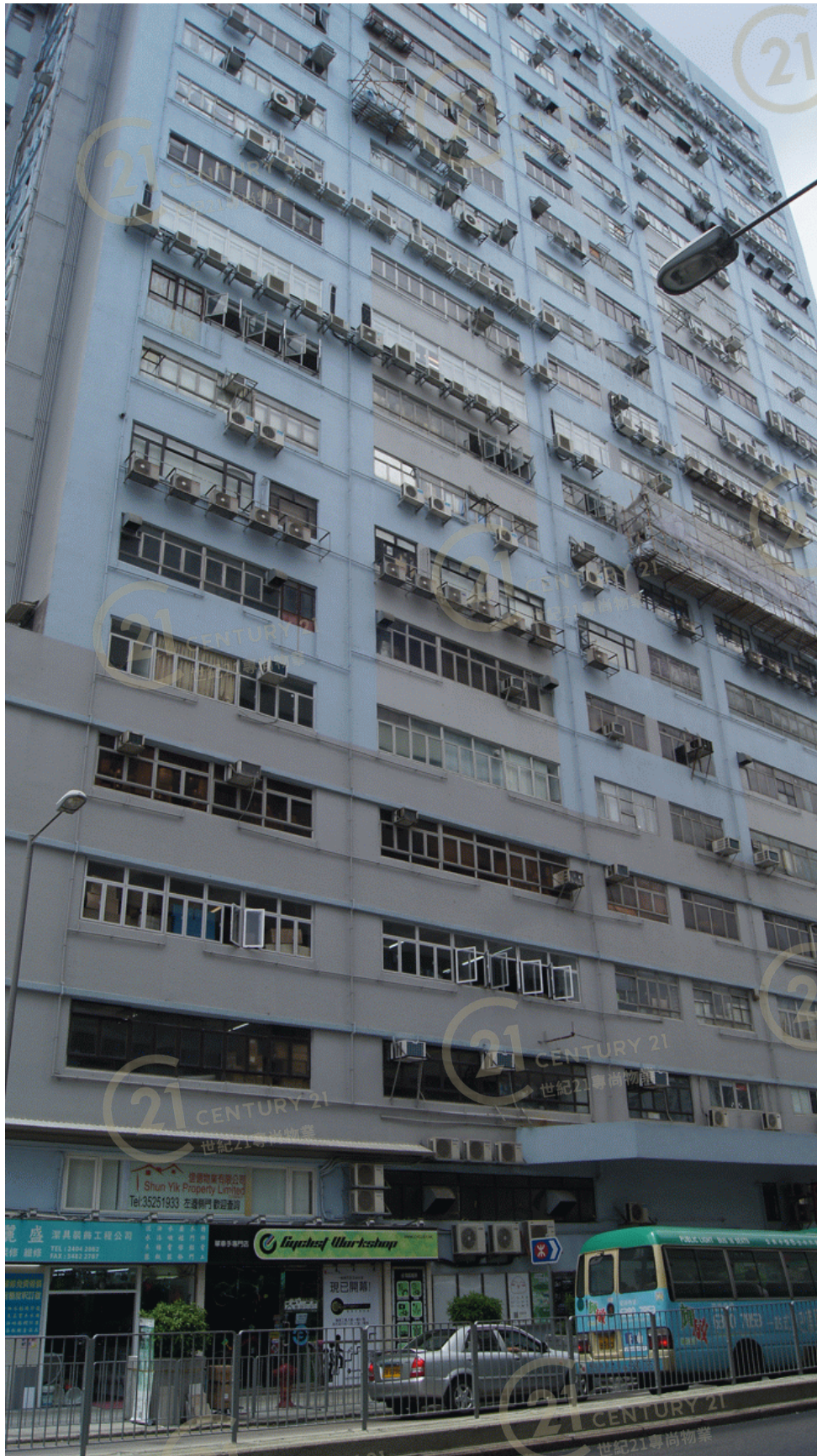
德榮工業大廈 Tak Wing Industrial Building
