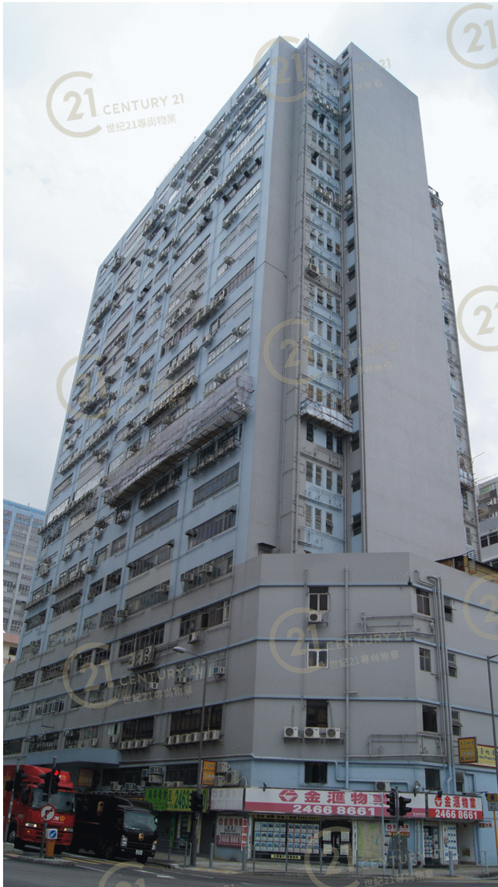
德榮工業大廈 Tak Wing Industrial Building
