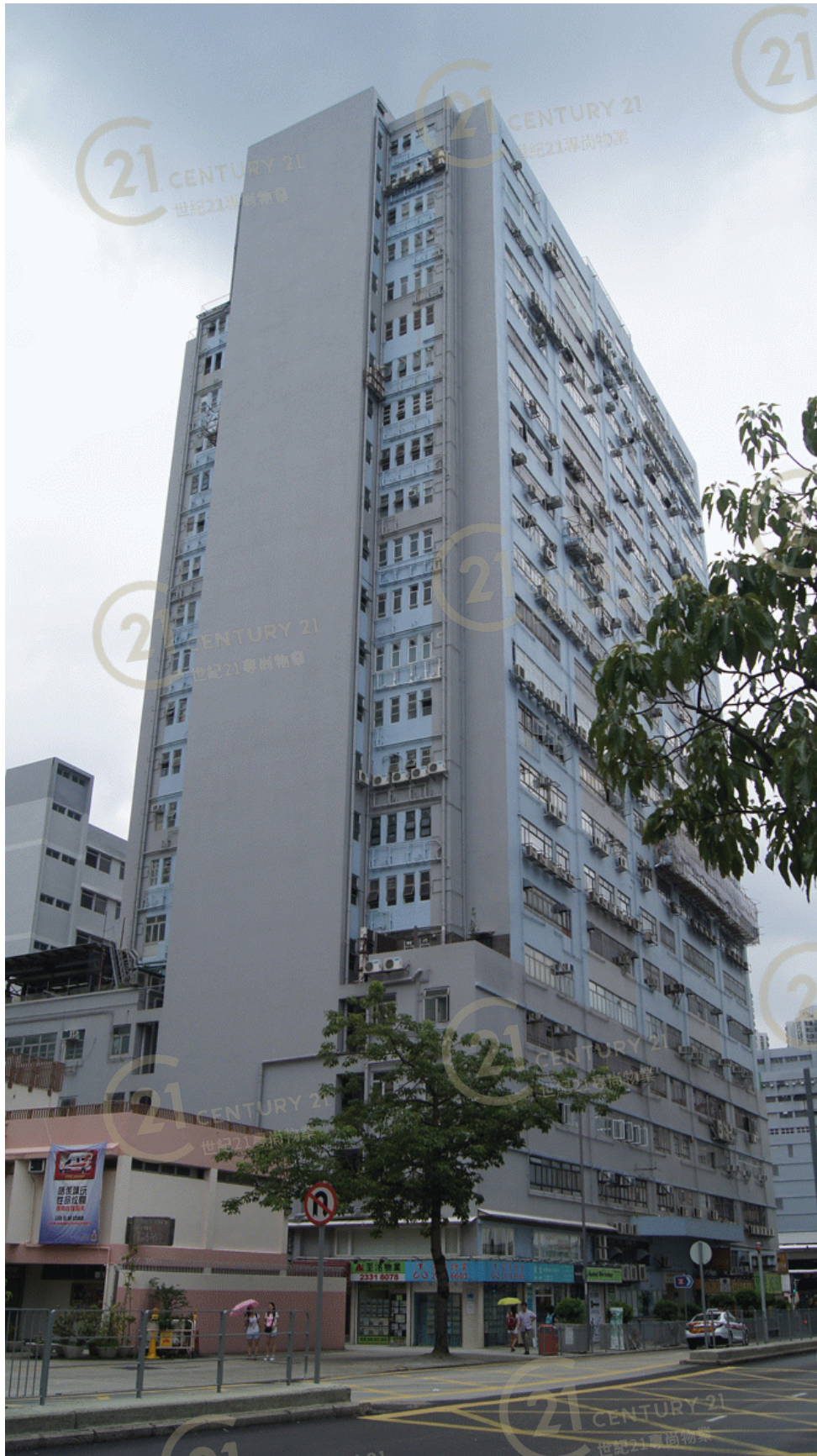
德榮工業大廈 Tak Wing Industrial Building
