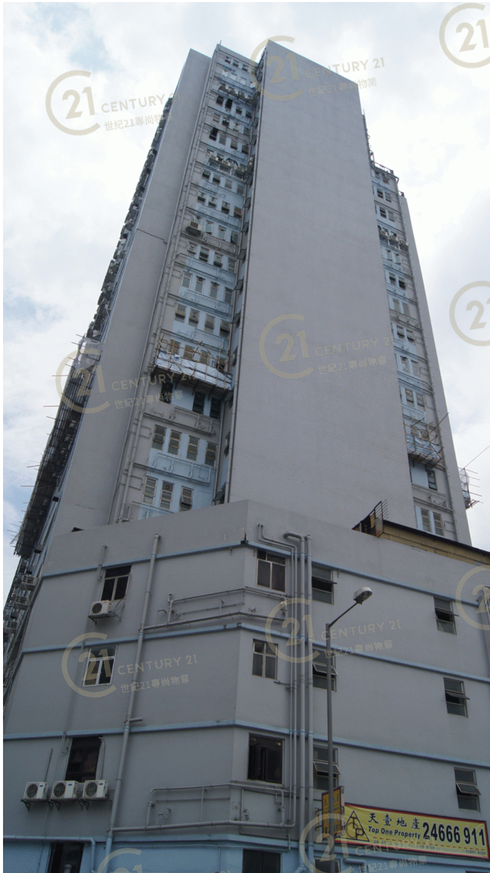
德榮工業大廈 Tak Wing Industrial Building
