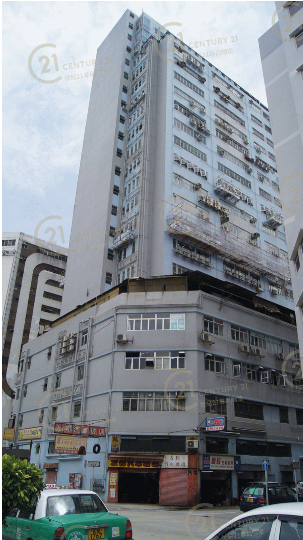
德榮工業大廈 Tak Wing Industrial Building
