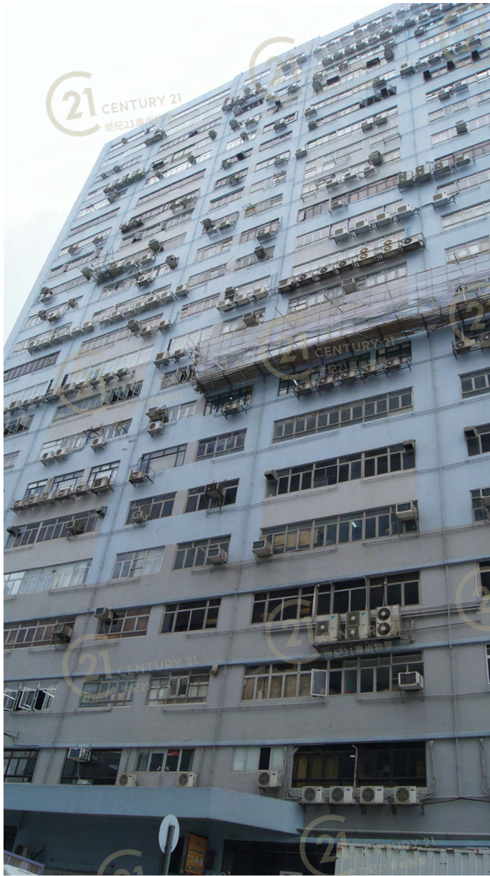
德榮工業大廈 Tak Wing Industrial Building
