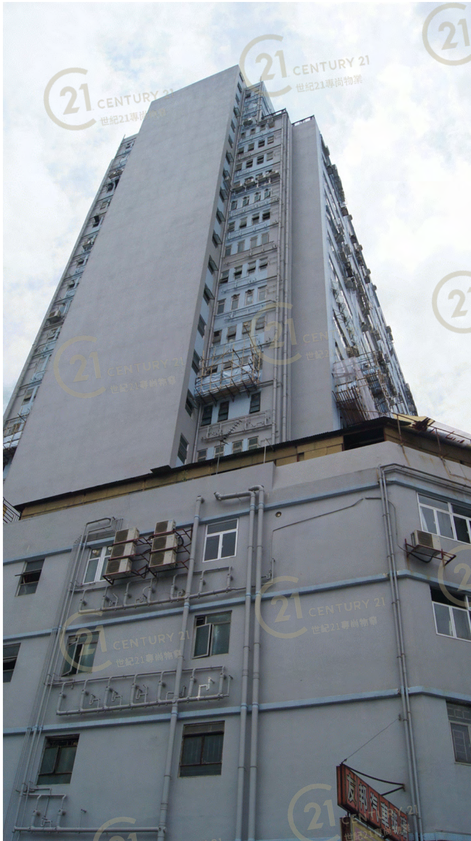
德榮工業大廈 Tak Wing Industrial Building
