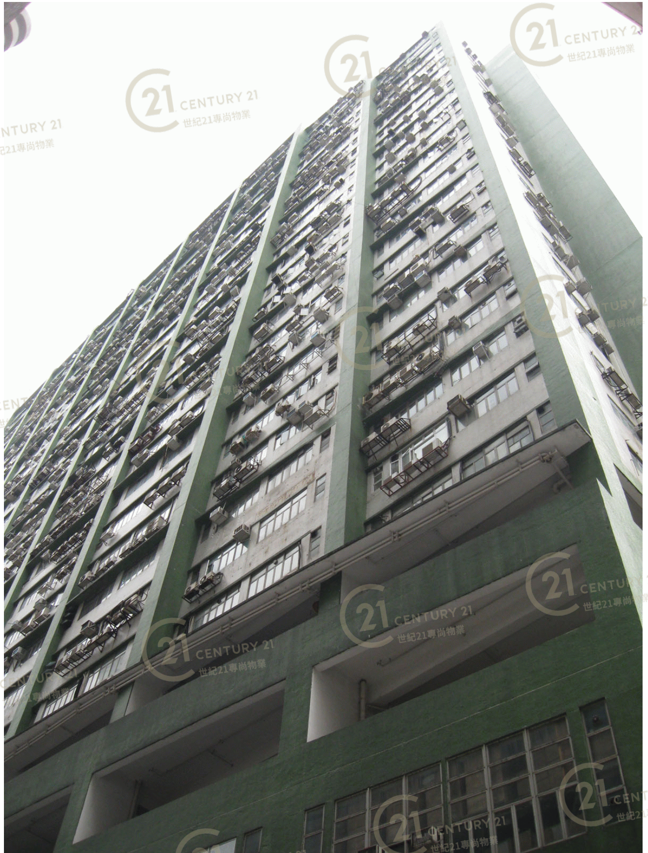
和豐工業中心 Well Fung Industrial Centre
