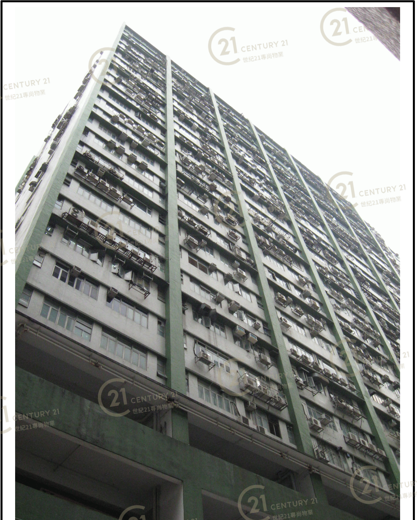
和豐工業中心 Well Fung Industrial Centre
