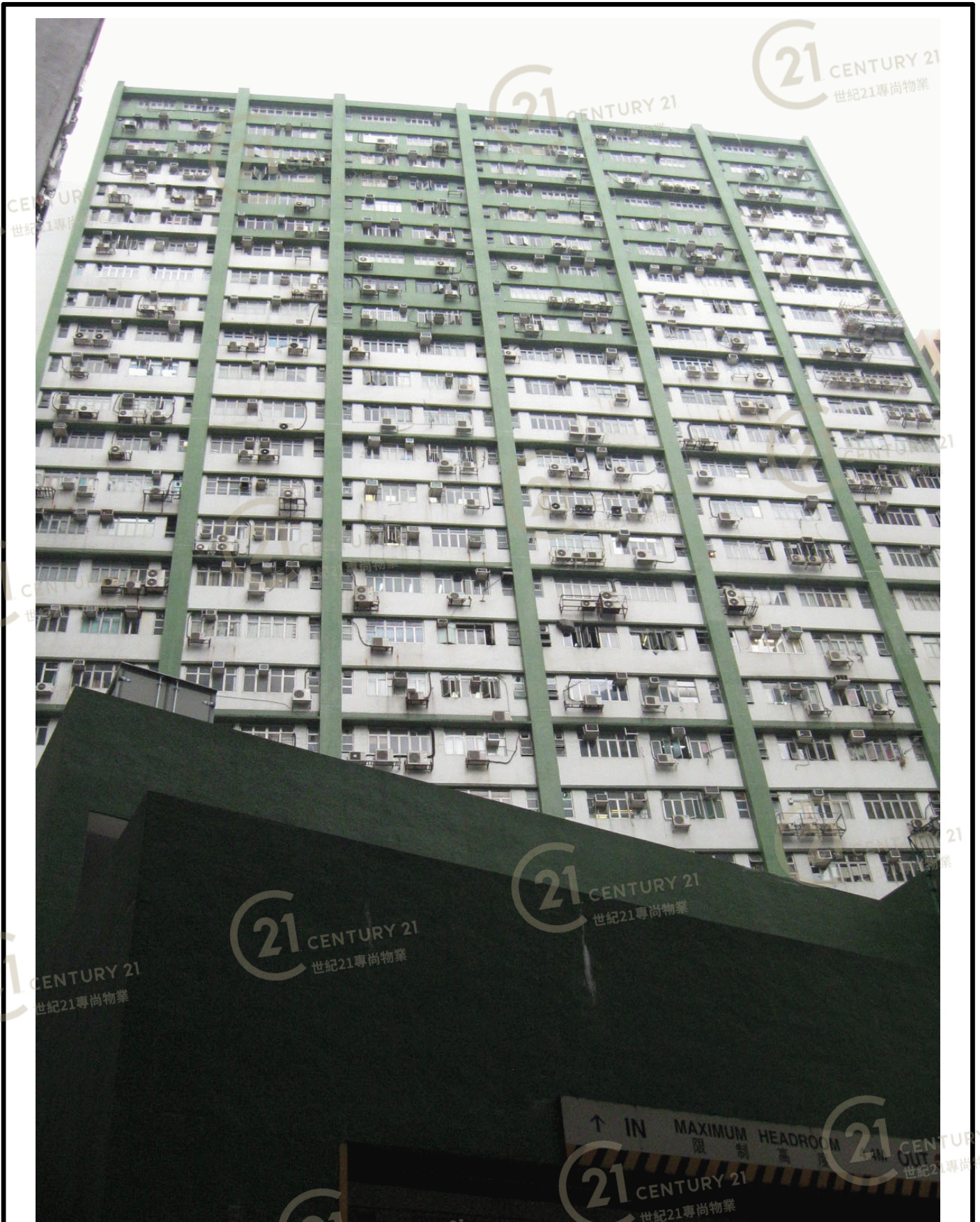
和豐工業中心 Well Fung Industrial Centre
