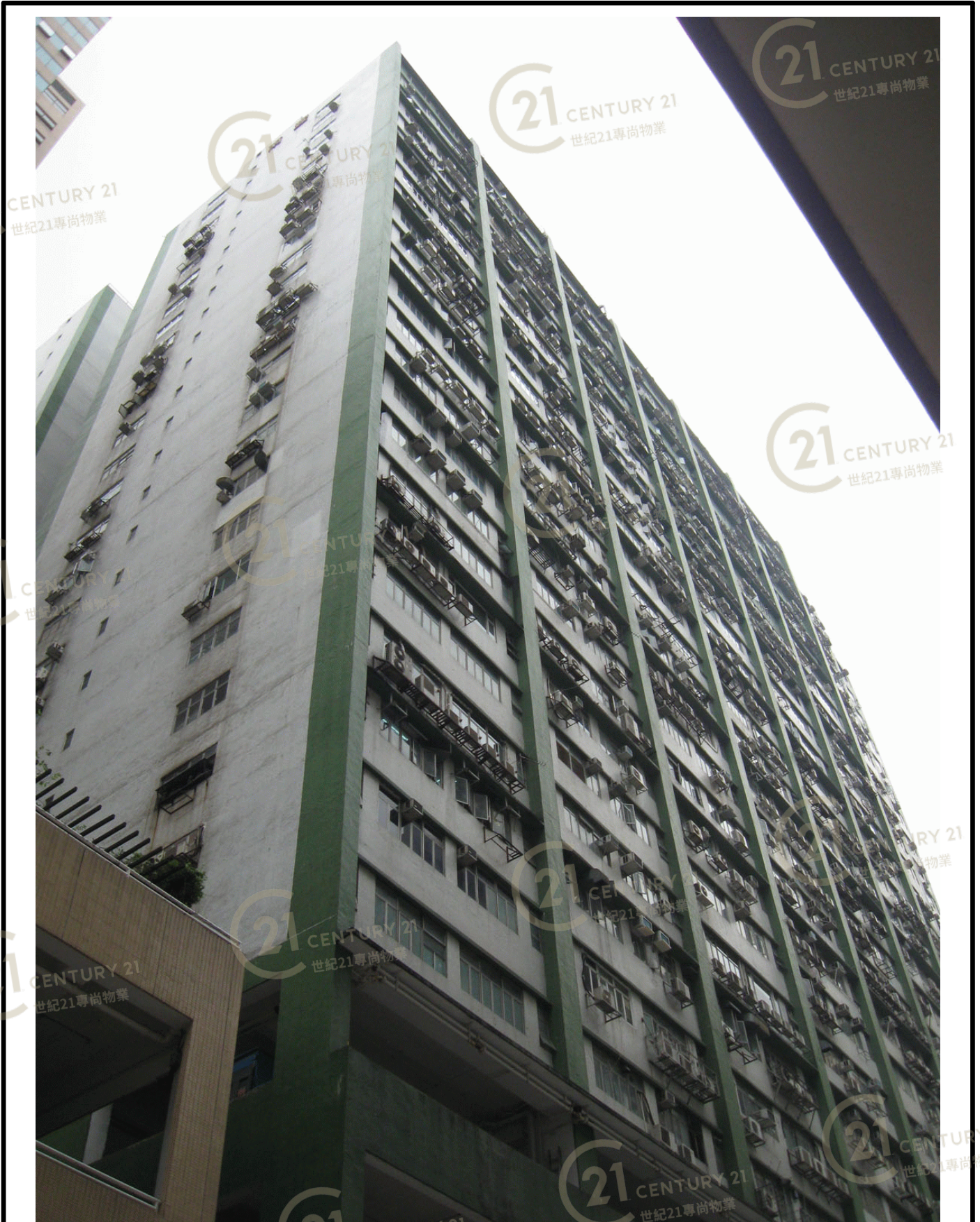
和豐工業中心 Well Fung Industrial Centre
