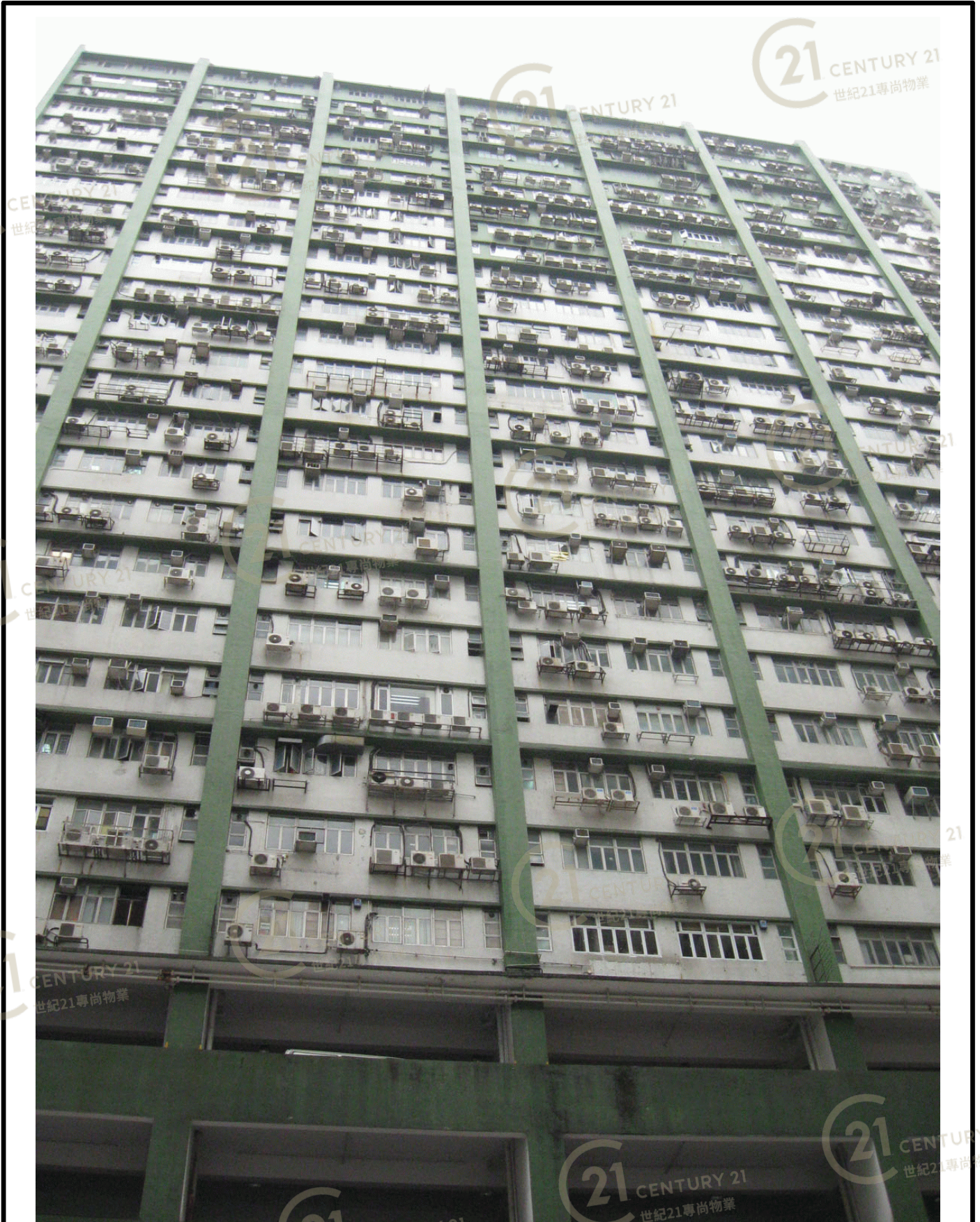
和豐工業中心 Well Fung Industrial Centre
