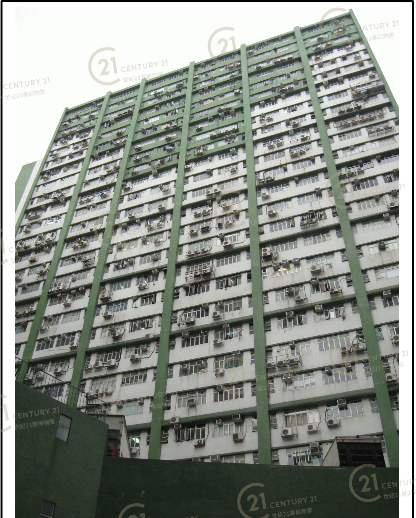
和豐工業中心 Well Fung Industrial Centre
