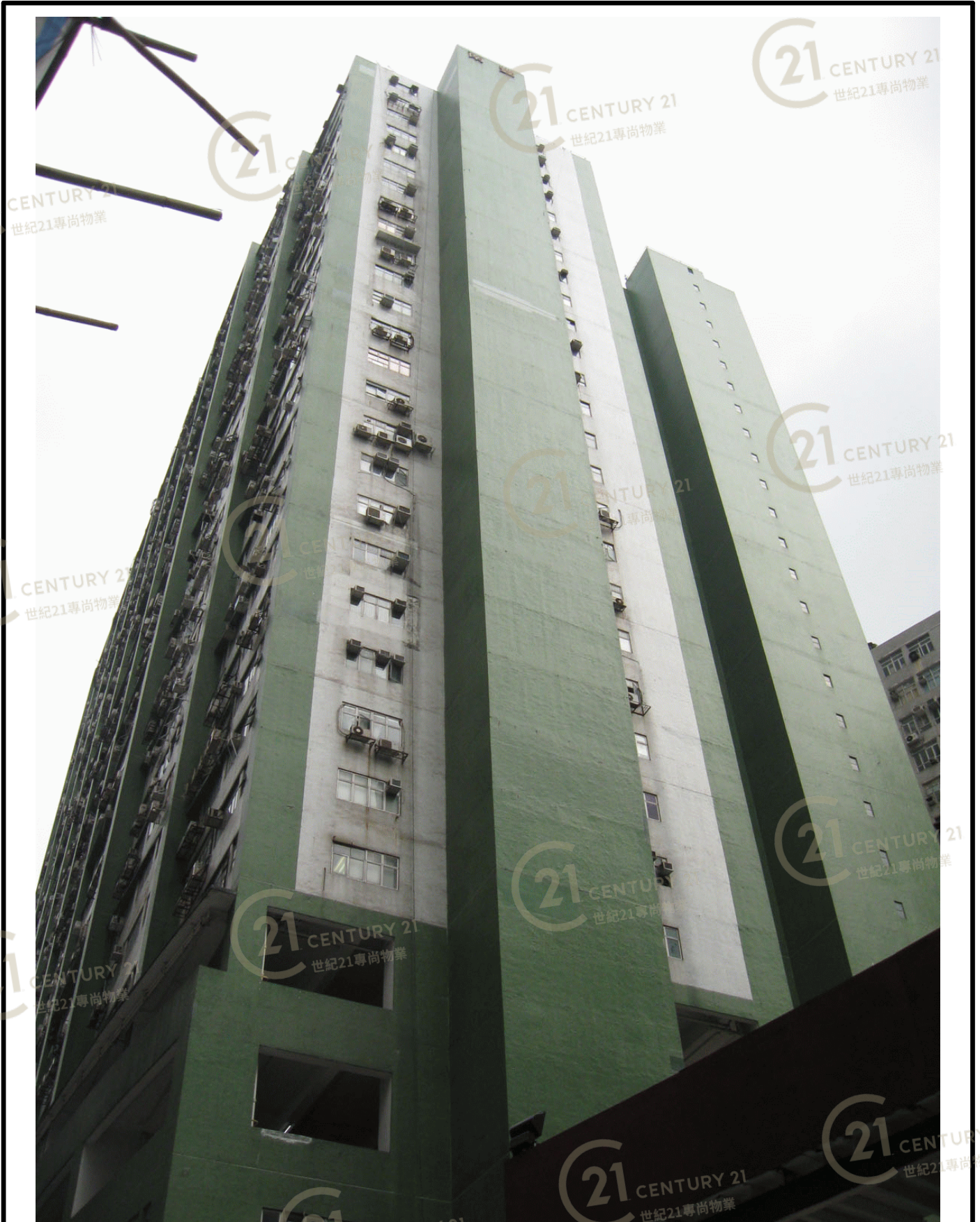
和豐工業中心 Well Fung Industrial Centre
