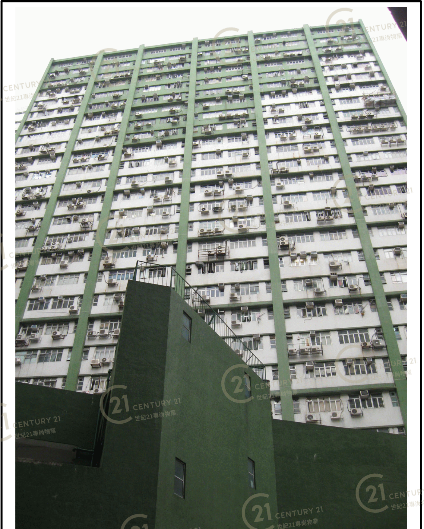
和豐工業中心 Well Fung Industrial Centre
