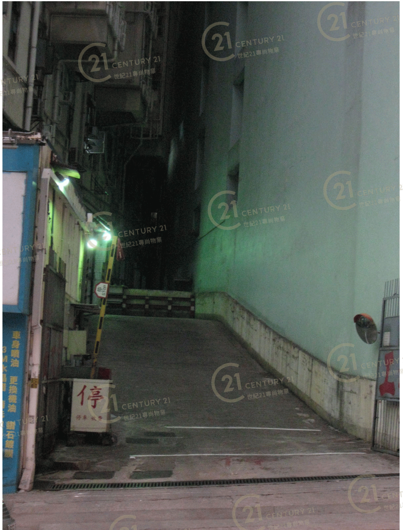
萬利工業大廈 Man Lee Industrial Building
