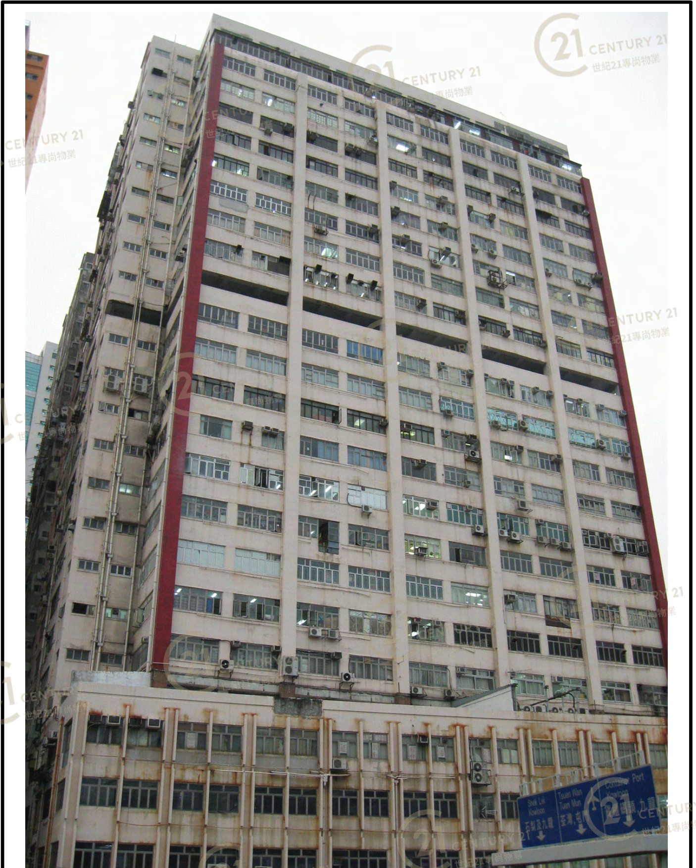
同珍工業大廈A座 Tung Chun Industrial Building Block A
