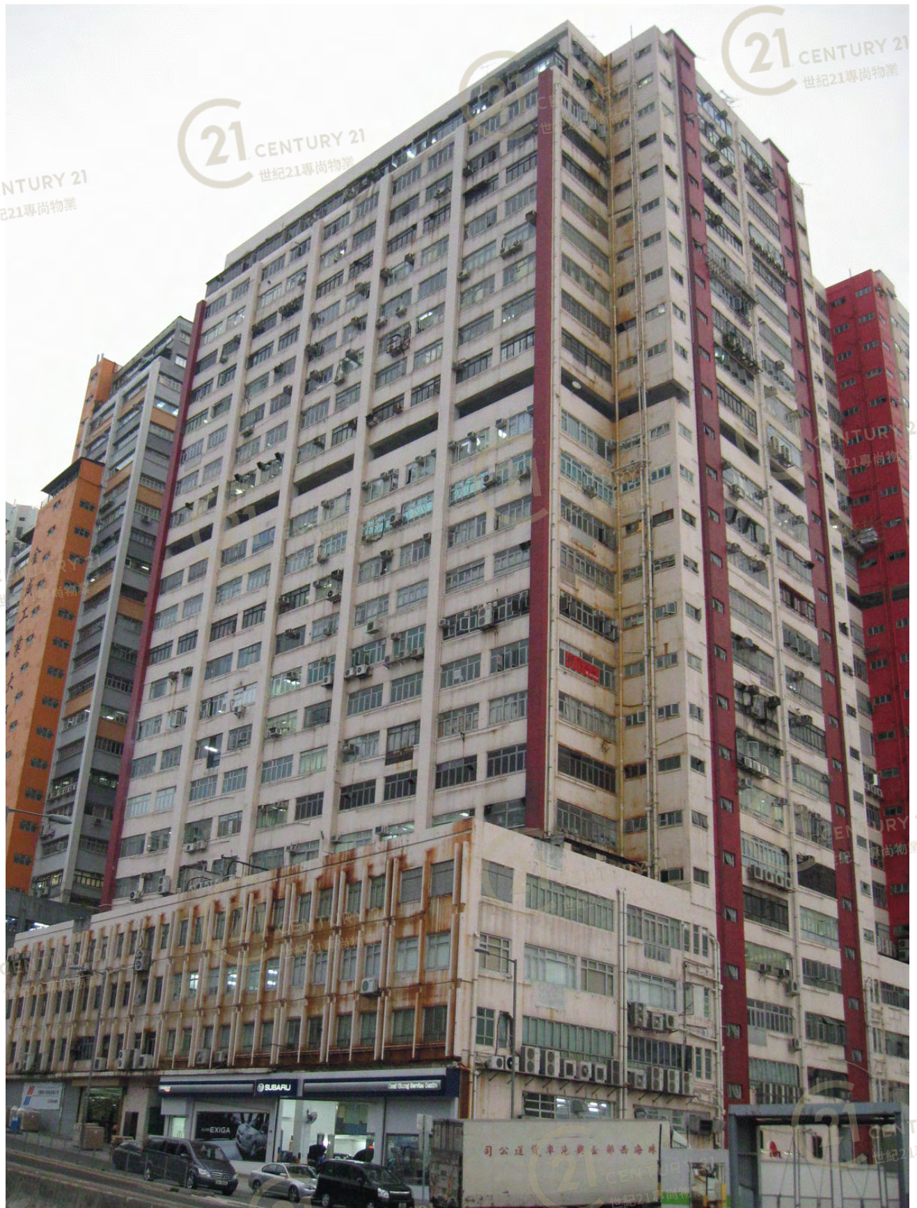
同珍工業大廈A座 Tung Chun Industrial Building Block A
