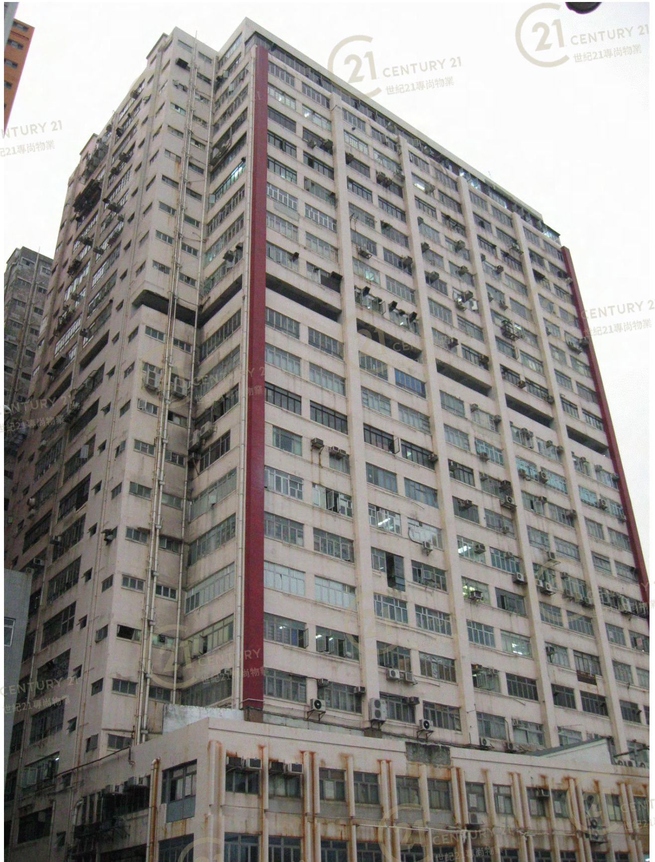
同珍工業大廈A座 Tung Chun Industrial Building Block A
