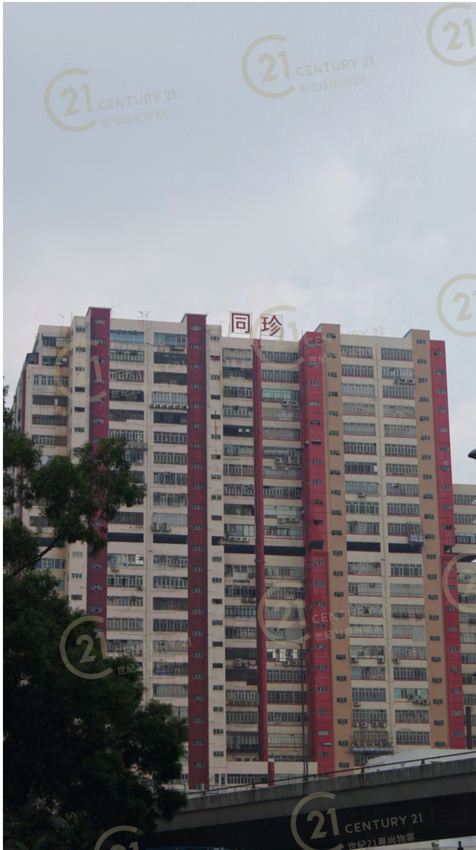
同珍工業大廈A座 Tung Chun Industrial Building Block A
