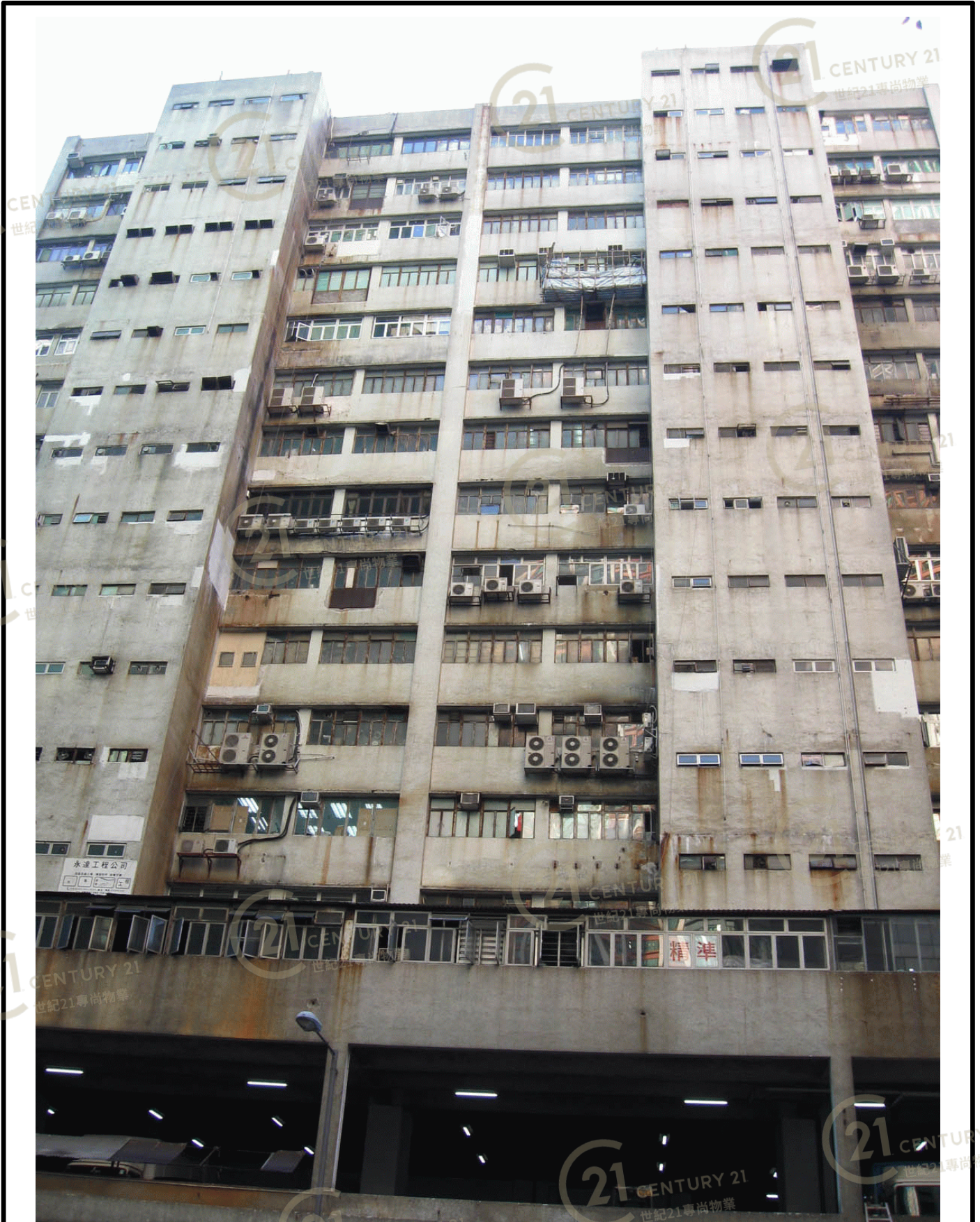
德士古道工業中心B座 Texaco Road Industrial Centre Block B
