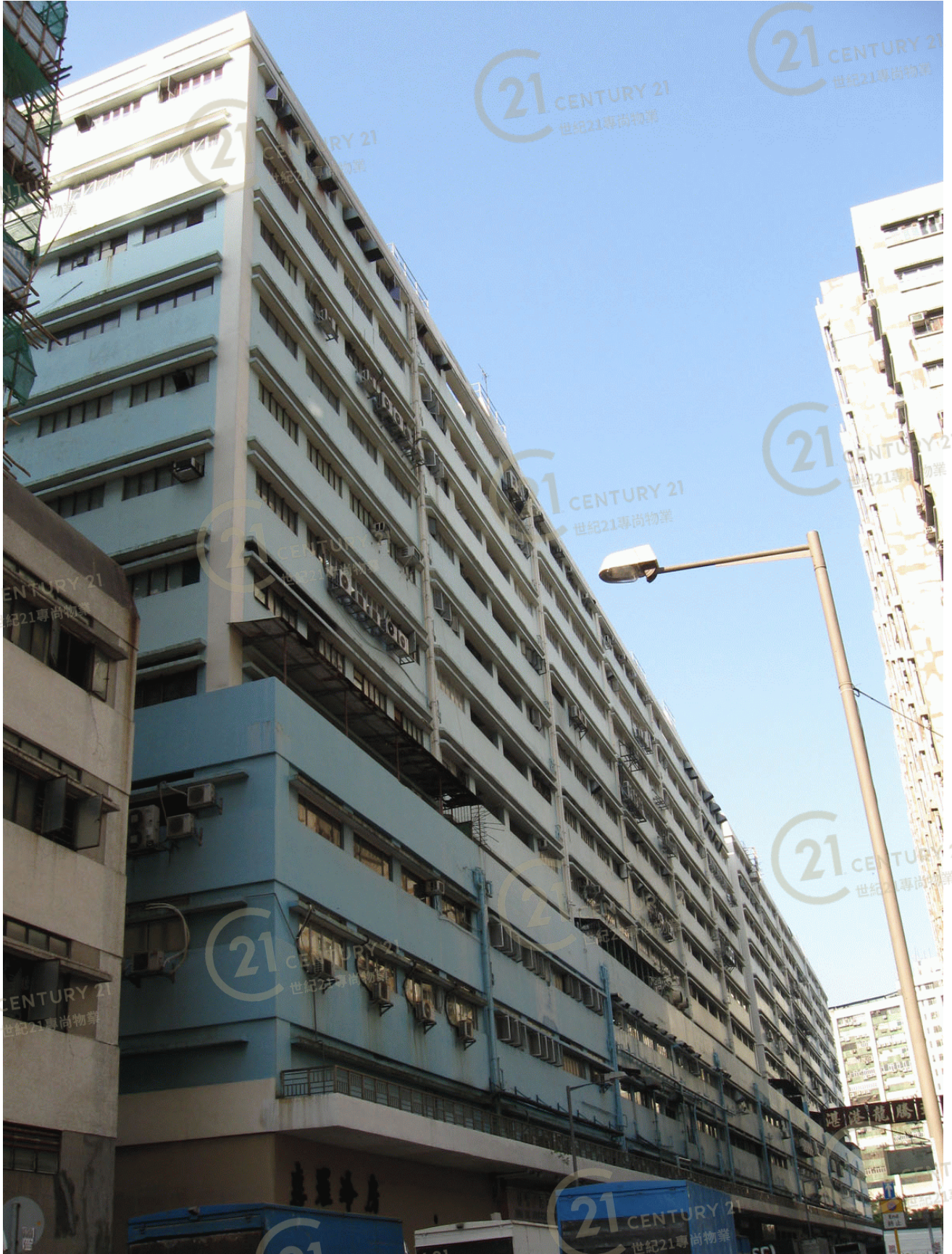
葵德工業中心1期 Kwai Tak Industrial Centre Block 1
