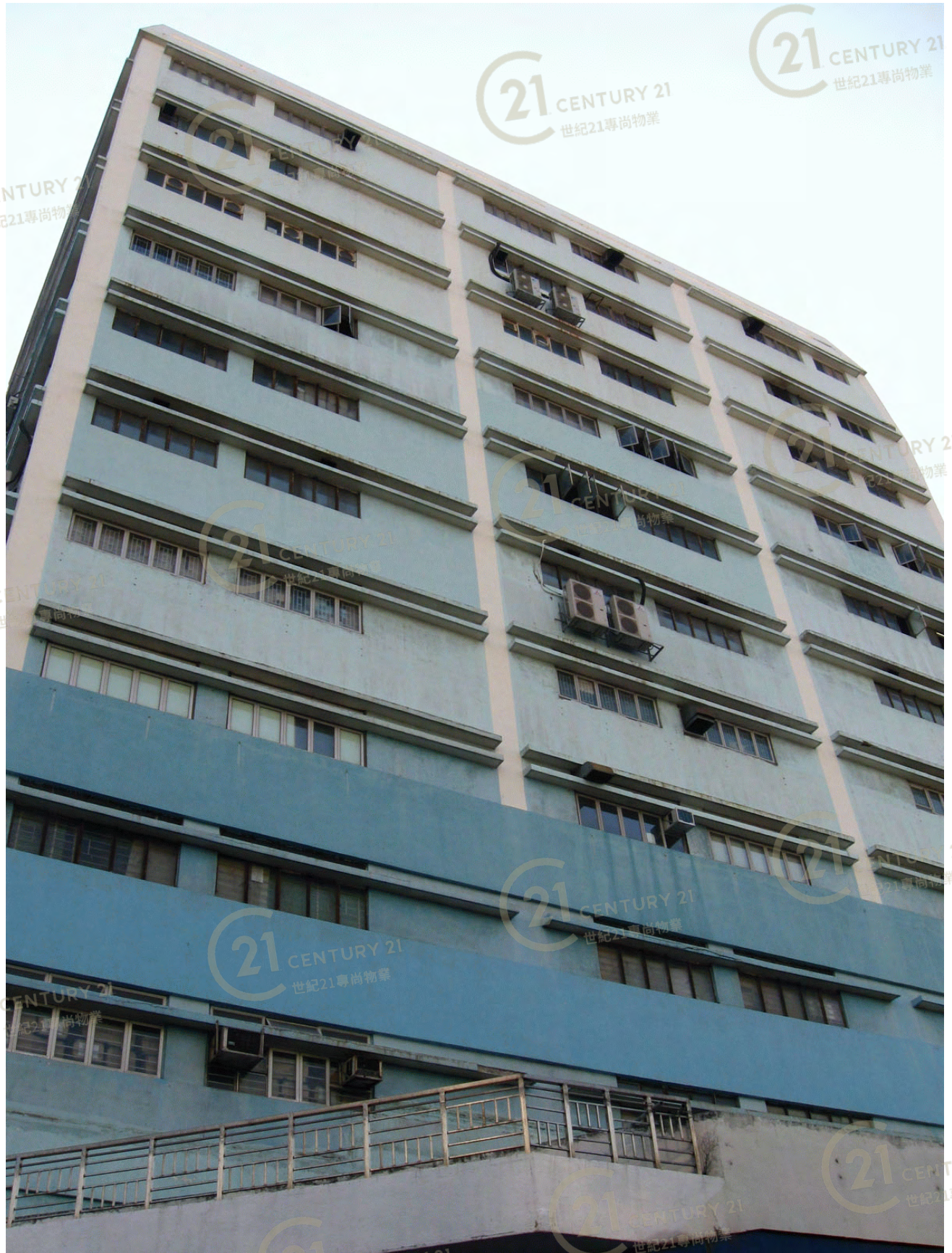
葵德工業中心1期 Kwai Tak Industrial Centre Block 1
