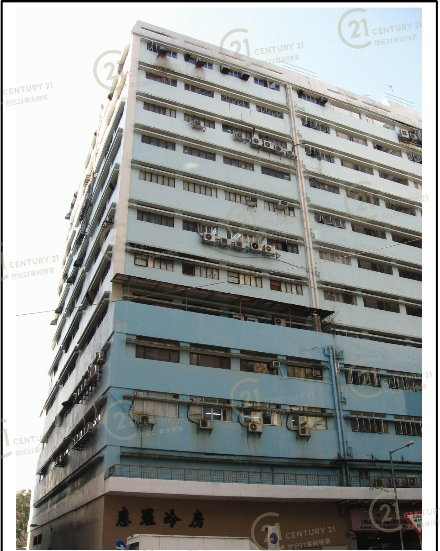
葵德工業中心1期 Kwai Tak Industrial Centre Block 1
