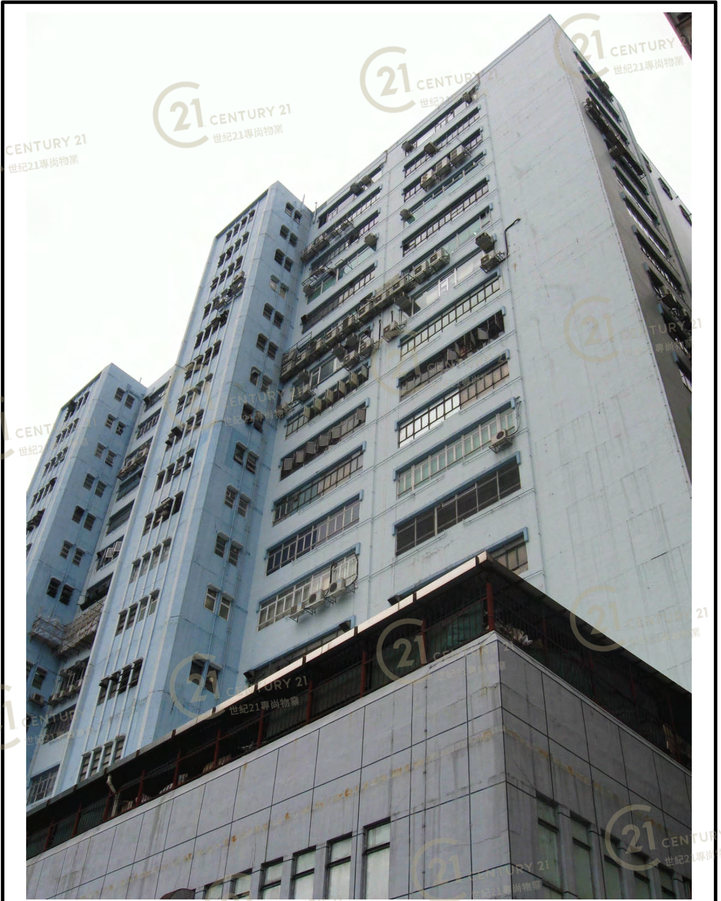
立泰工業中心2期 Leader Industrial Centre Phase 2
