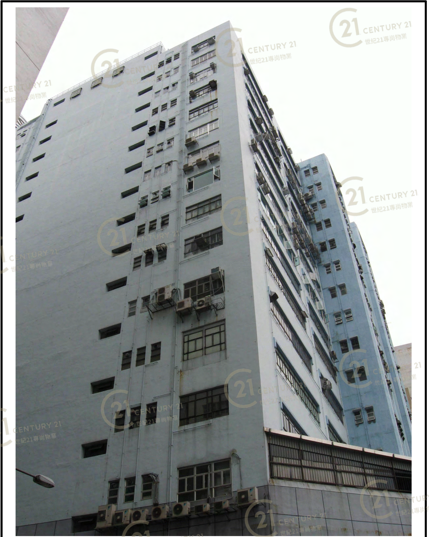
立泰工業中心1期 Leader Industrial Centre Phase 1
