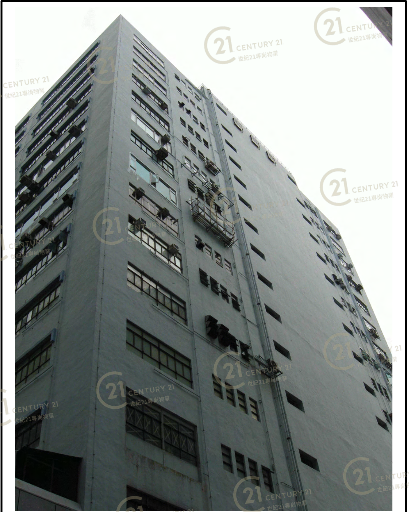
立泰工業中心1期 Leader Industrial Centre Phase 1
