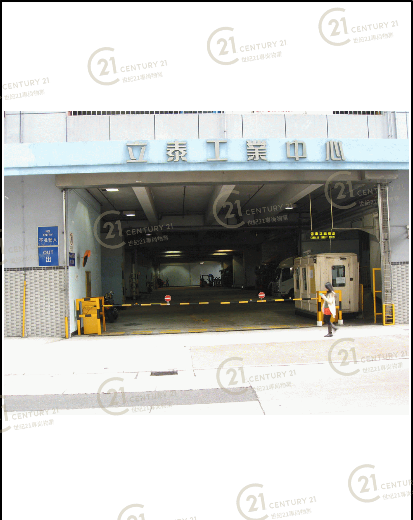
立泰工業中心1期 Leader Industrial Centre Phase 1
