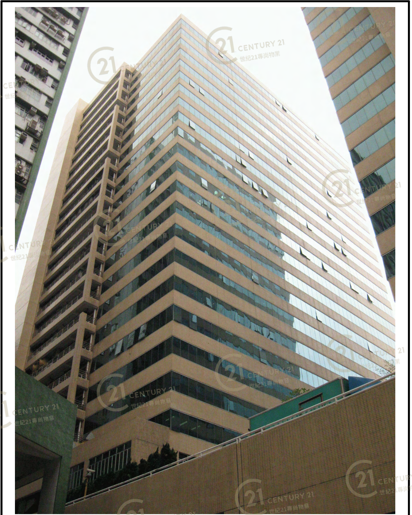
麗晶中心B座 Regent Centre Tower B
