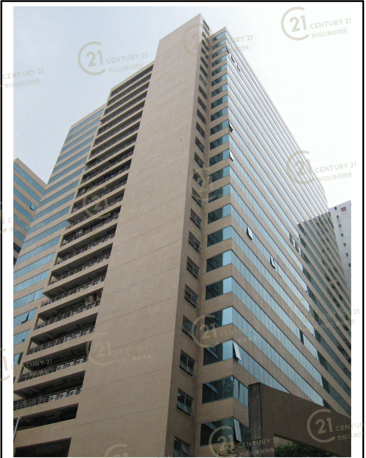
麗晶中心B座 Regent Centre Tower B
