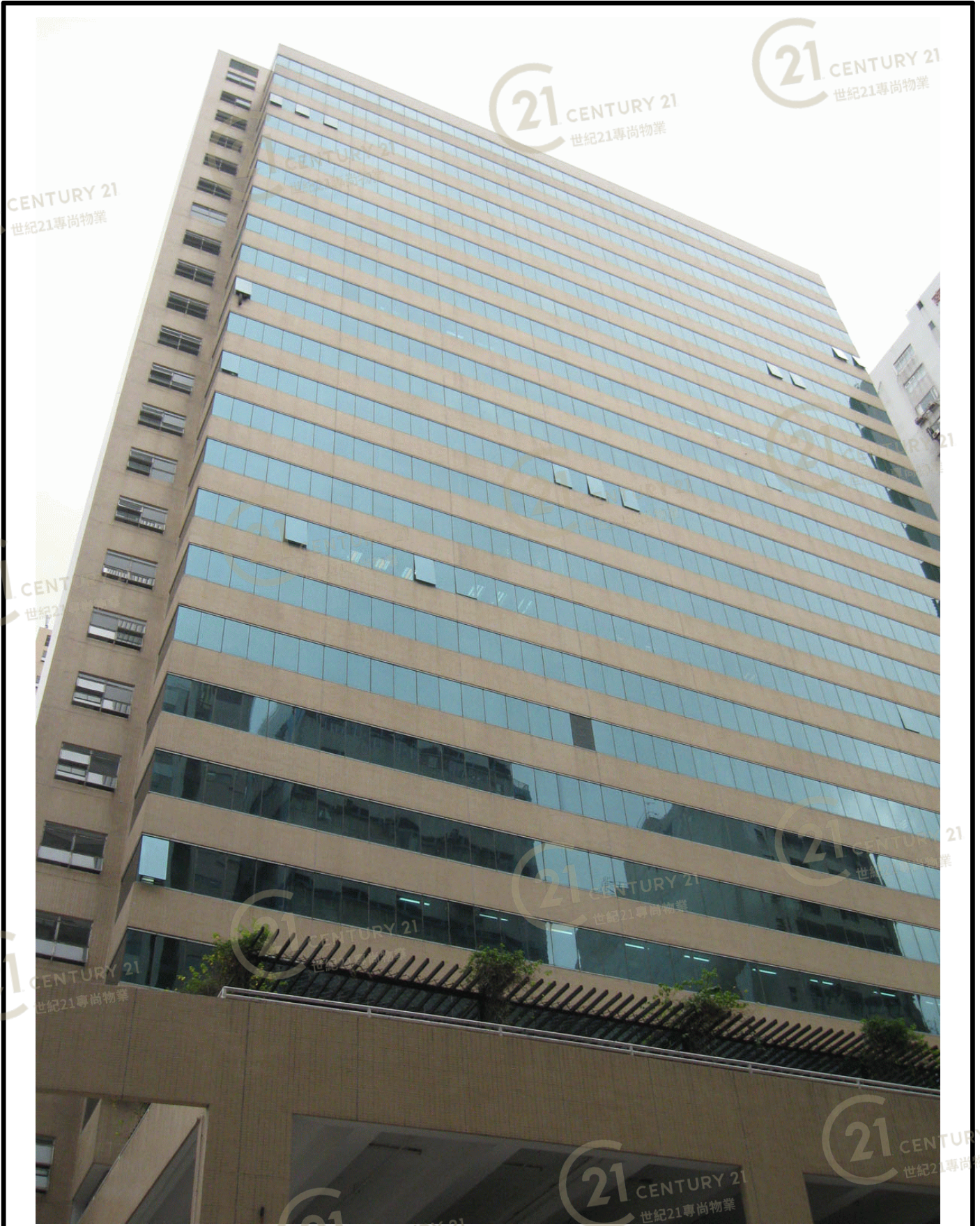
麗晶中心B座 Regent Centre Tower B
