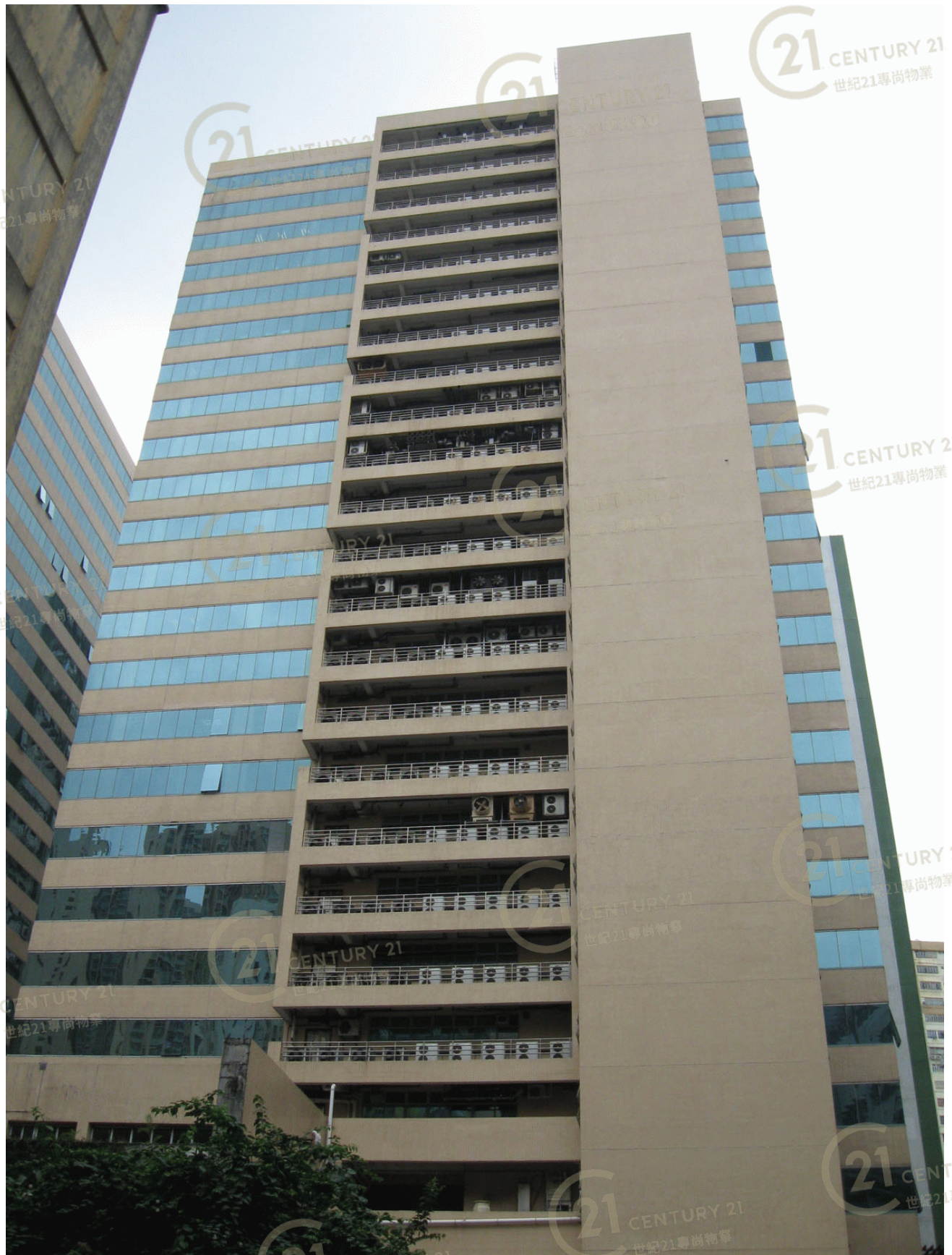
麗晶中心B座 Regent Centre Tower B
