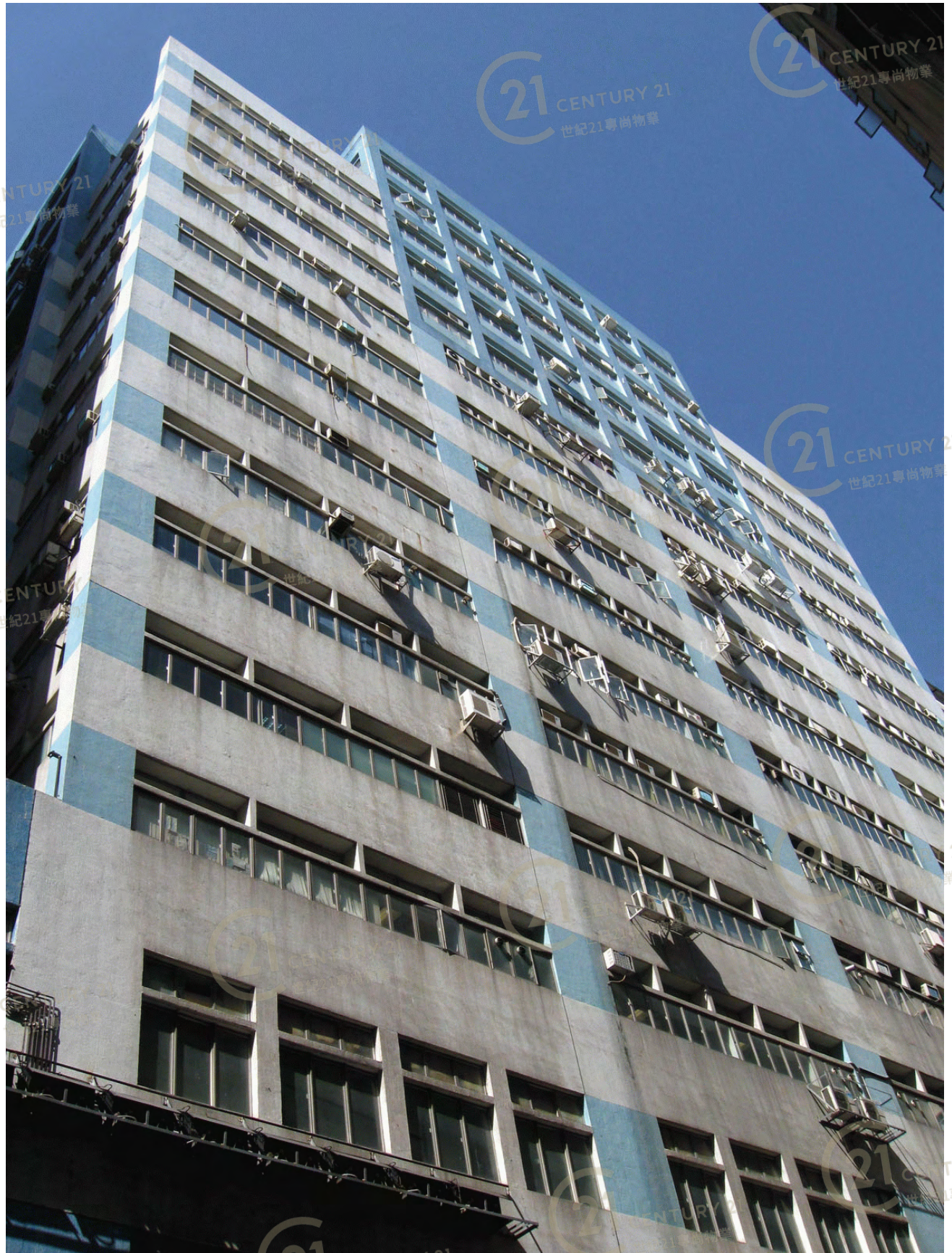
葵昌中心 Kwai Cheong Centre
