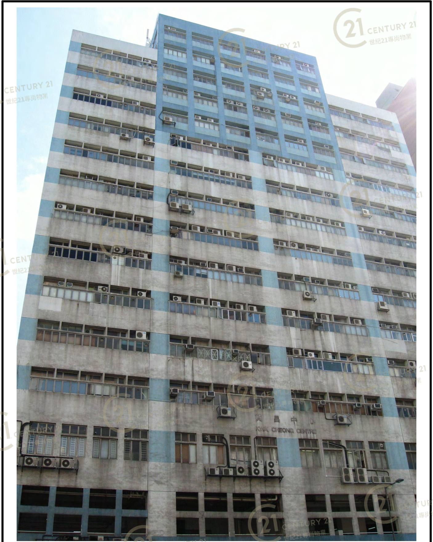
葵昌中心 Kwai Cheong Centre
