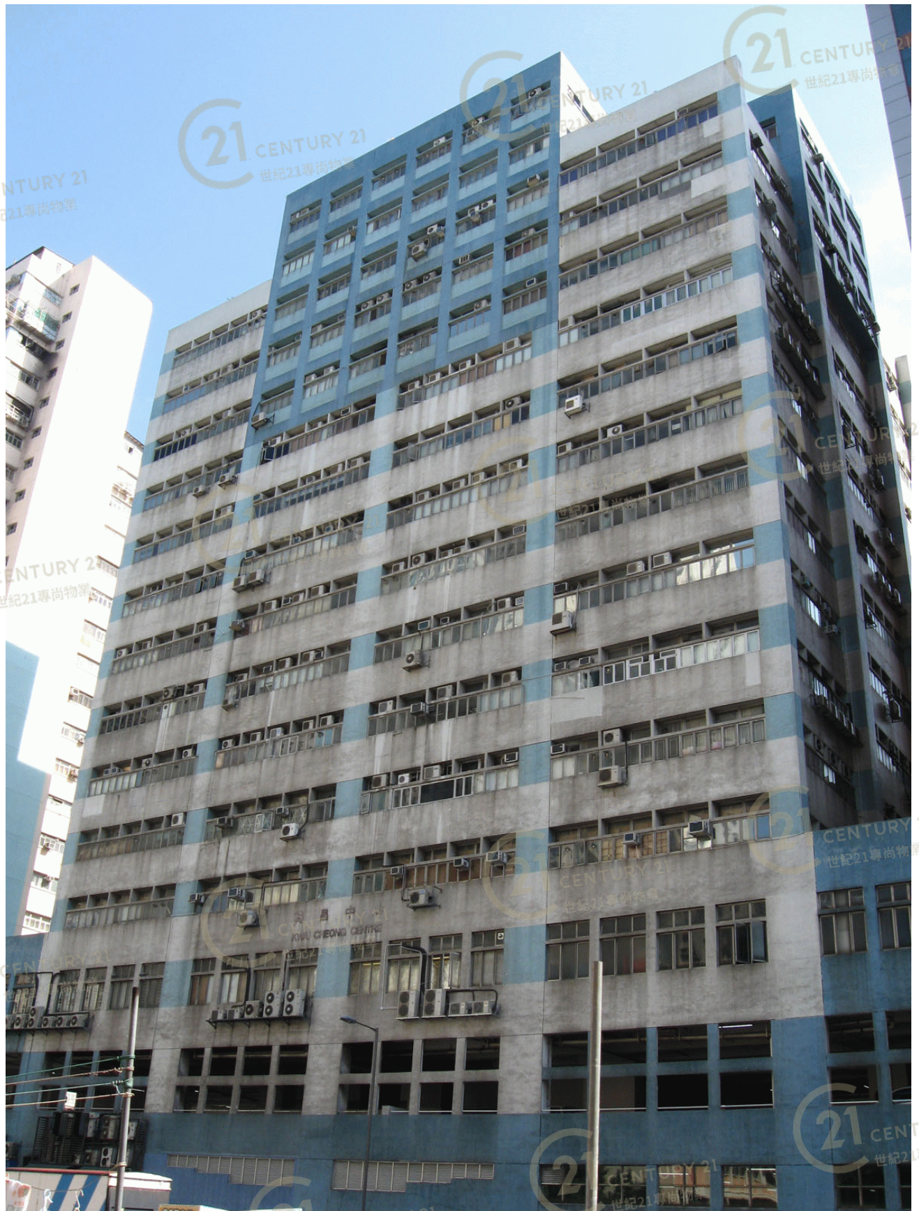
葵昌中心 Kwai Cheong Centre
