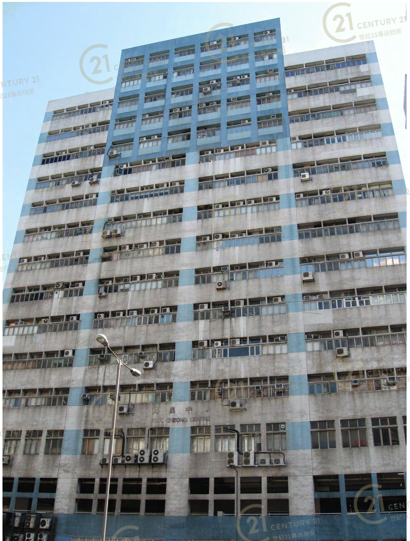
葵昌中心 Kwai Cheong Centre
