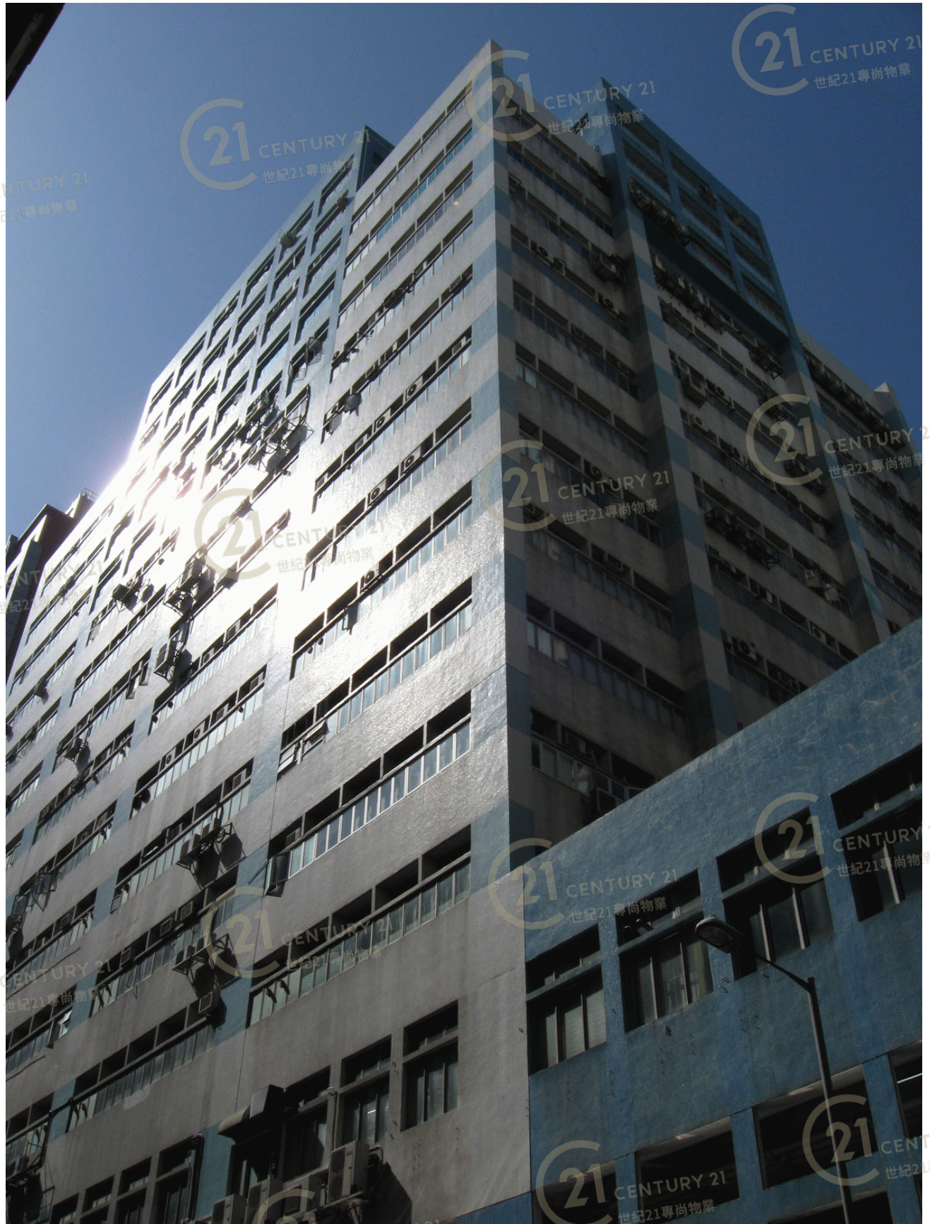
葵昌中心 Kwai Cheong Centre
