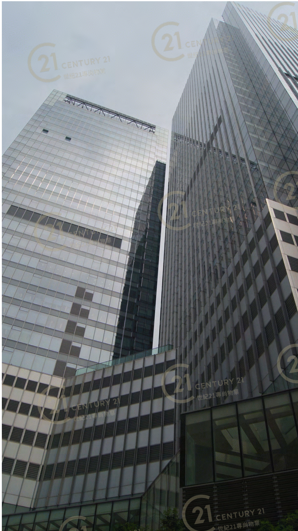
九龍貿易中心A座 Kowloon Commercial Centre Tower A
