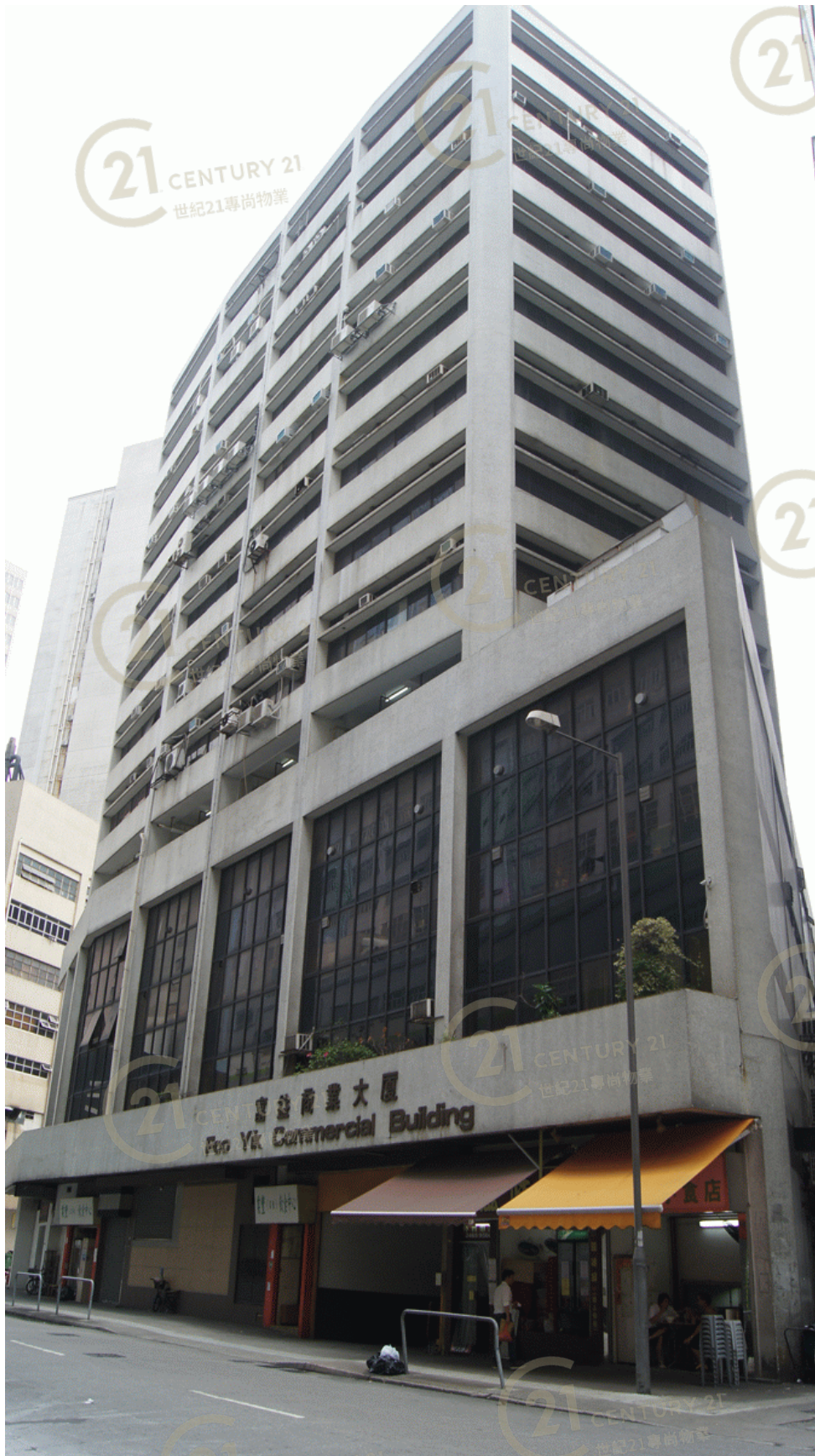
富益商業大廈 Foo Yik Commercial Building
