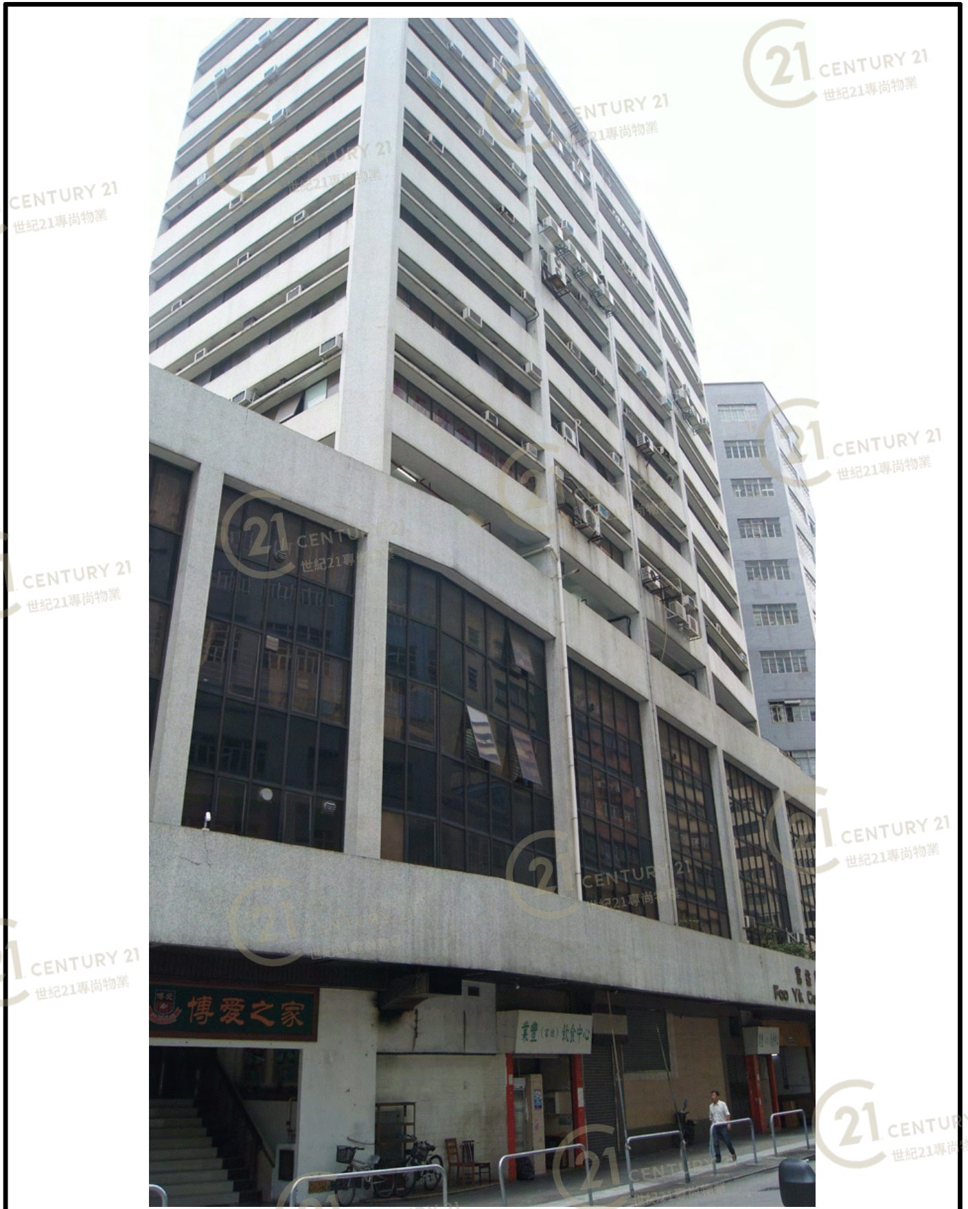
富益商業大廈 Foo Yik Commercial Building
