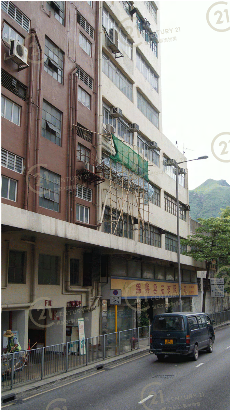
屯門工業中心D座 Tuen Mun Industrial Centre Block D
