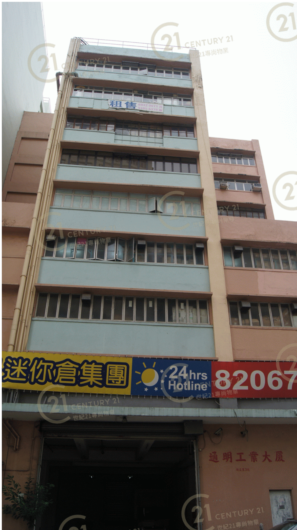
通明工業大廈 Tung Ming Industrial Building
