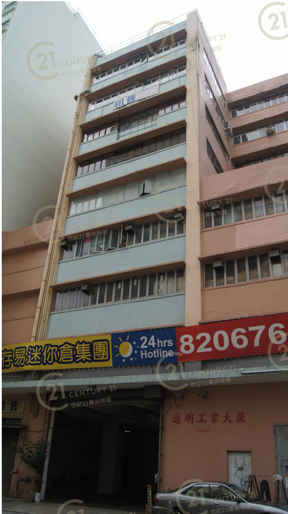
通明工業大廈 Tung Ming Industrial Building
