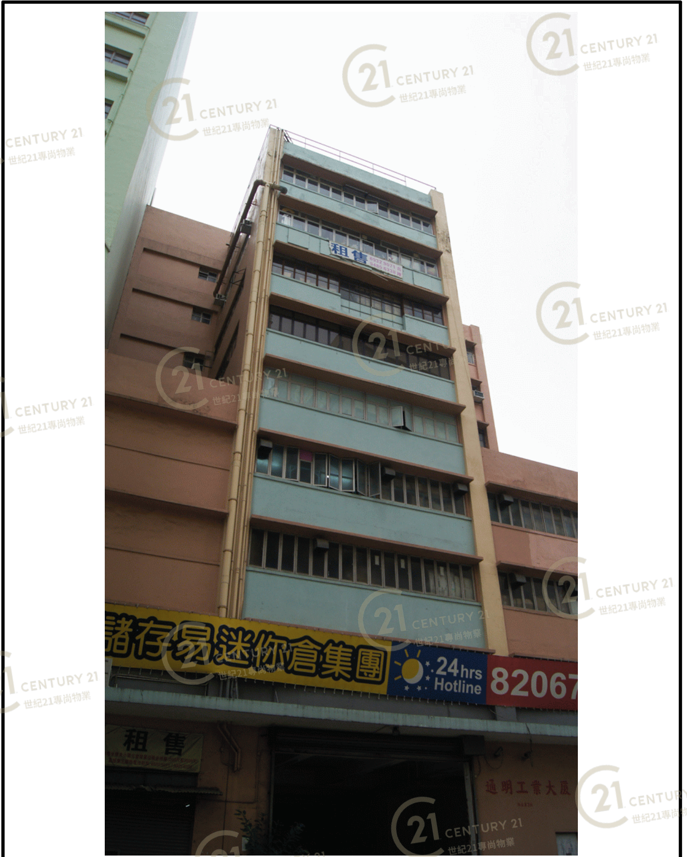
通明工業大廈 Tung Ming Industrial Building
