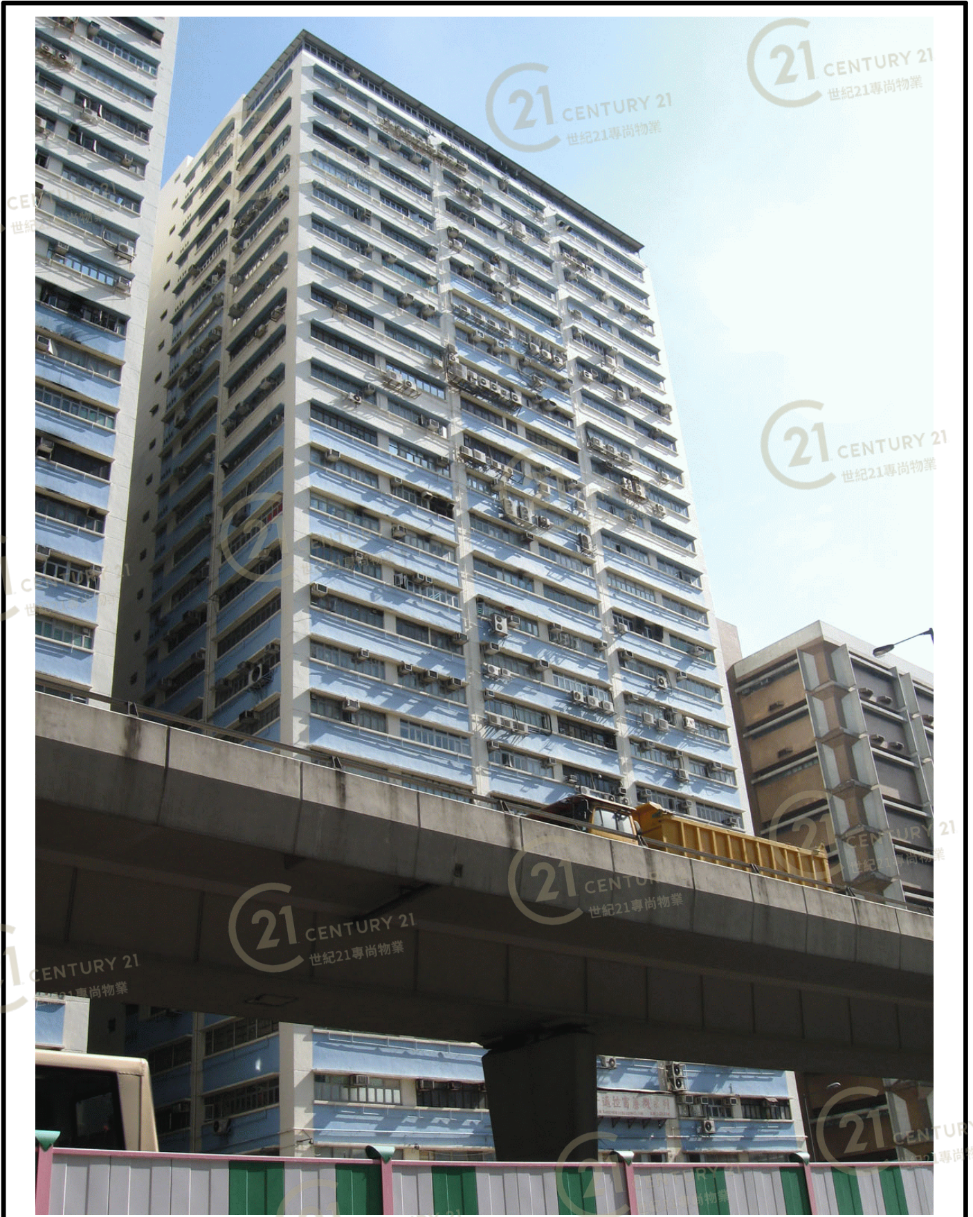
金龍工業中心3座 Golden Dragon Industrial Centre Block 3
