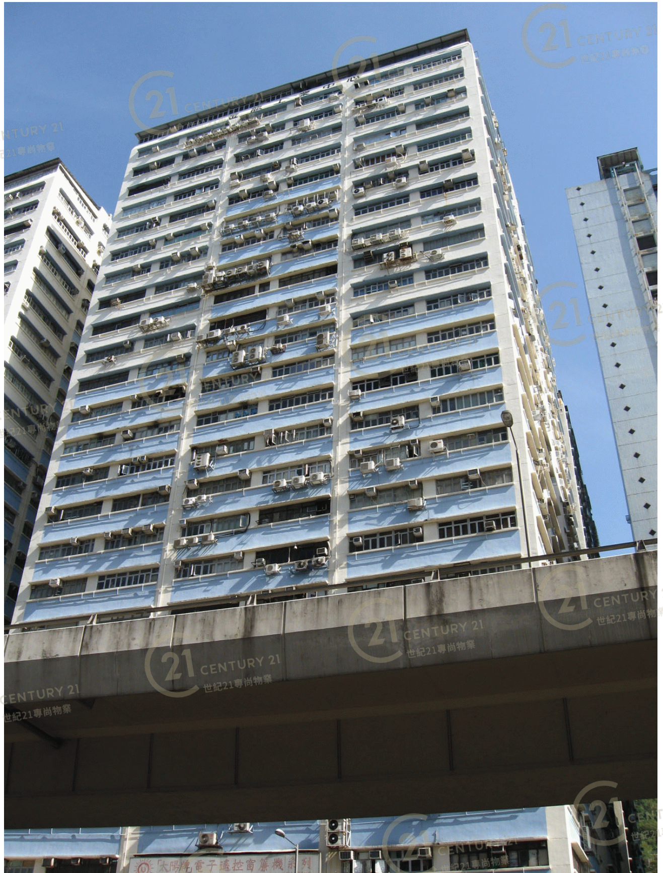
金龍工業中心3座 Golden Dragon Industrial Centre Block 3
