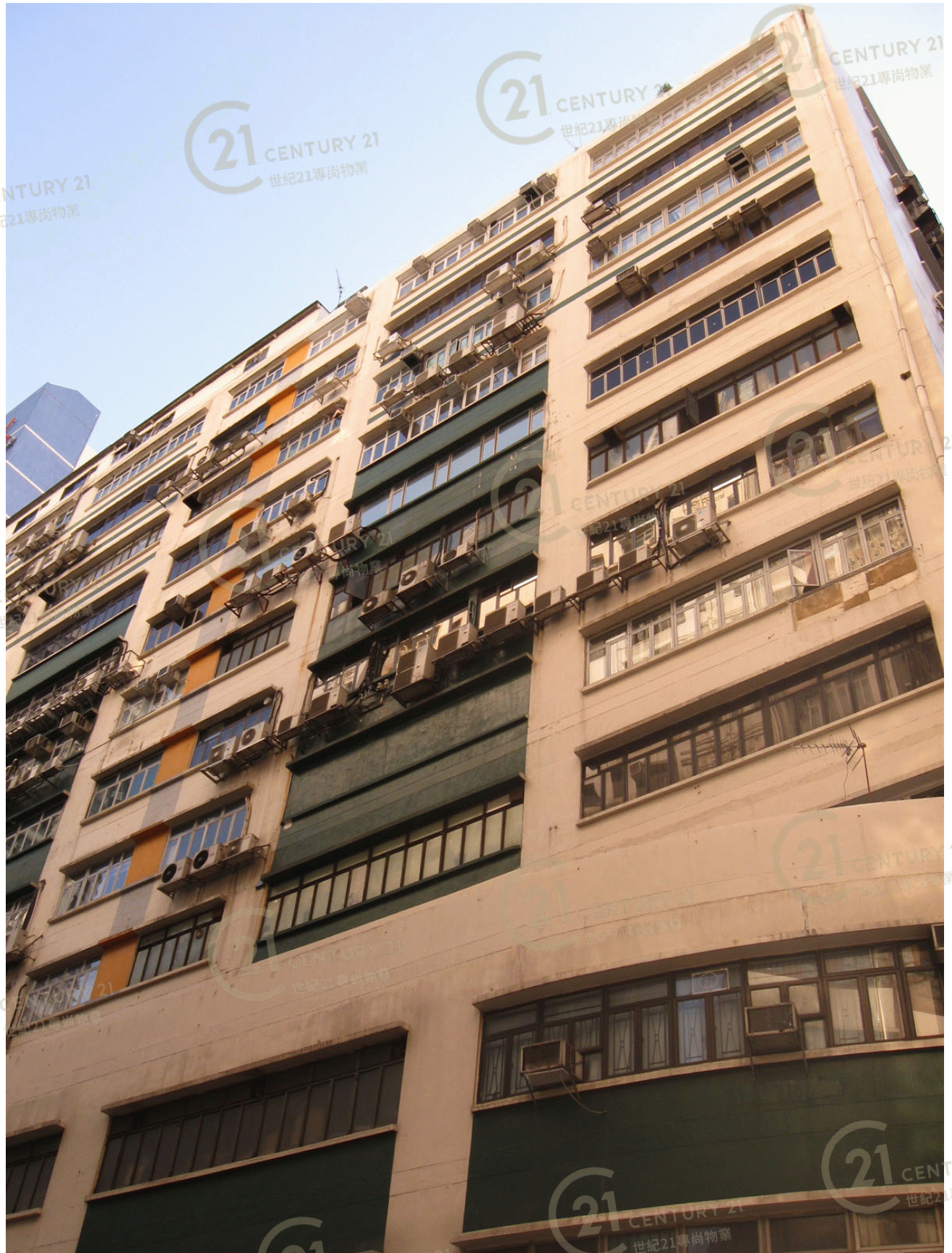
業豐工業大廈 (葵涌) Yip Fung Industrial Building (KC)
