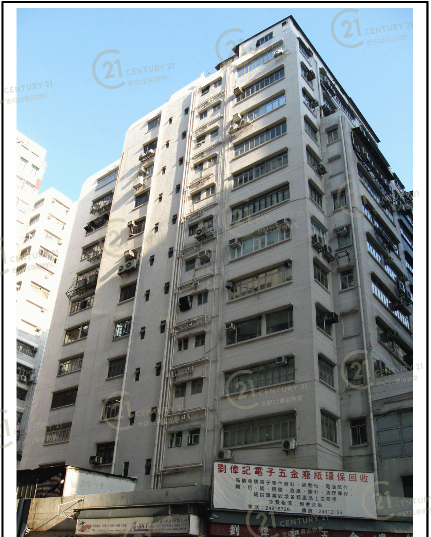
業豐工業大廈 (葵涌) Yip Fung Industrial Building (KC)
