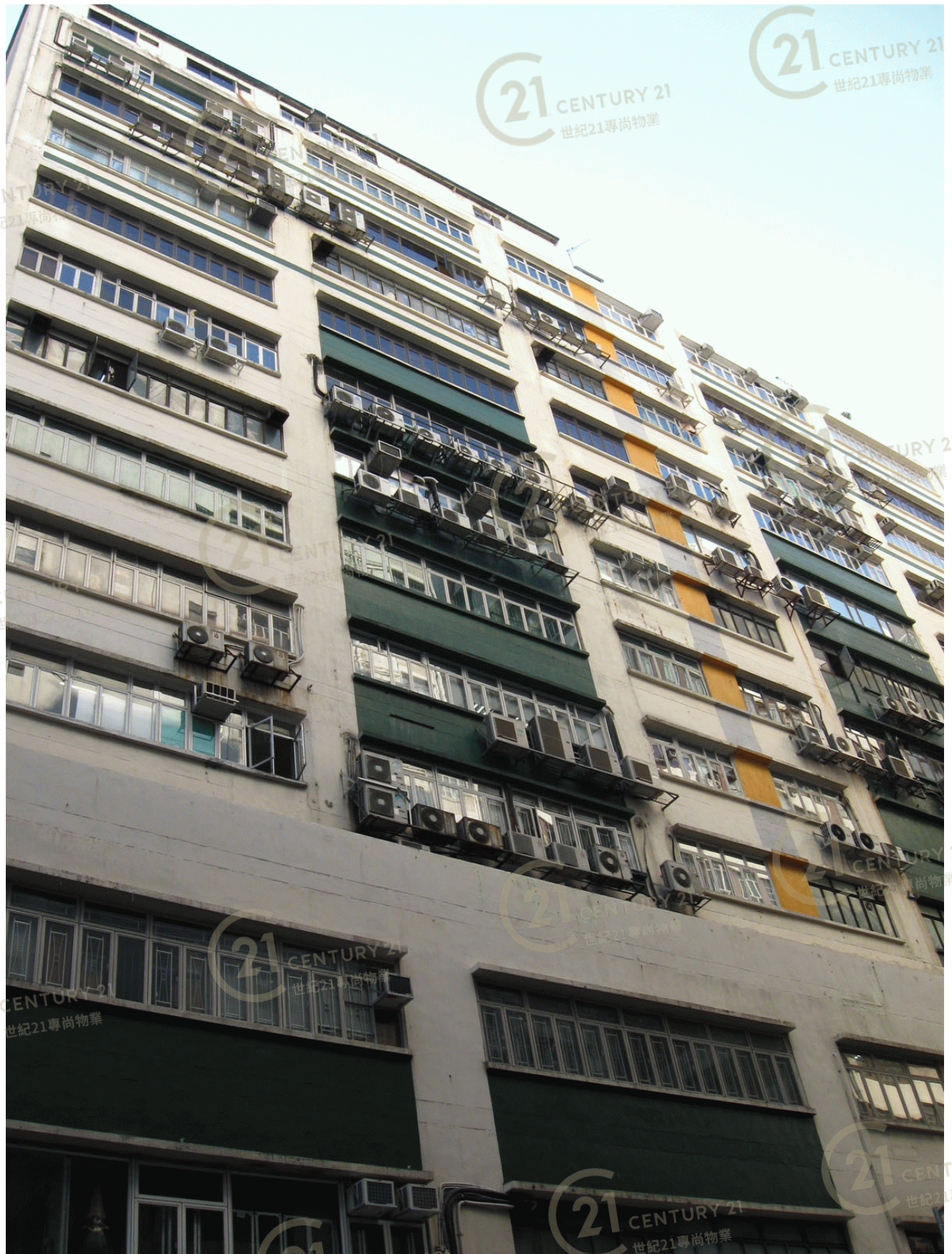
業豐工業大廈 (葵涌) Yip Fung Industrial Building (KC)
