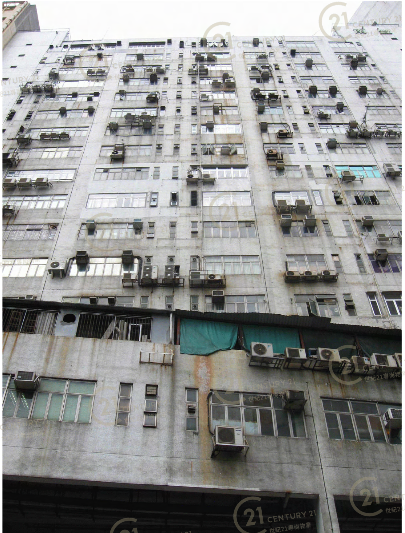
德豐工業中心2期 Tak Fung Industrial Centre Block 2
