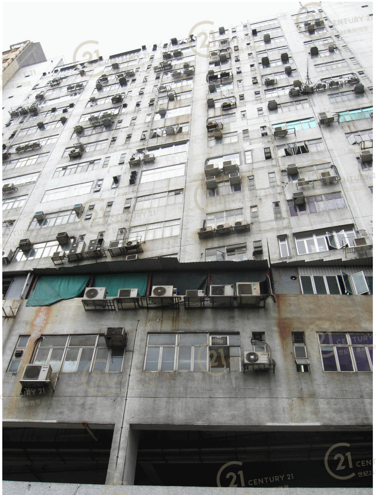
德豐工業中心2期 Tak Fung Industrial Centre Block 2
