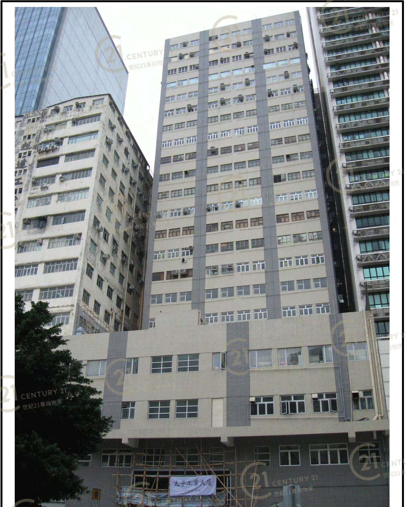
太子工業大廈 Prince Industrial Building
