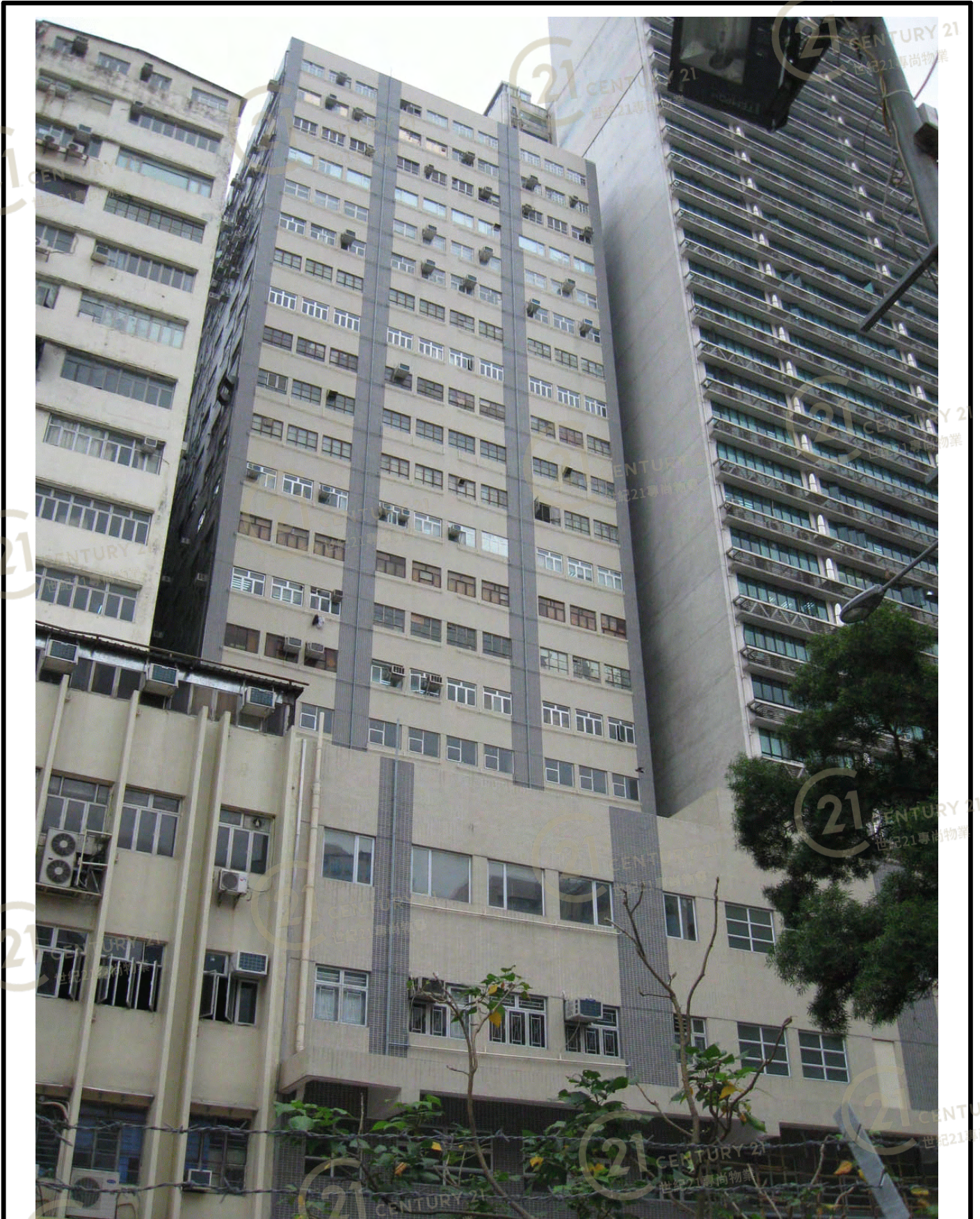
太子工業大廈 Prince Industrial Building
