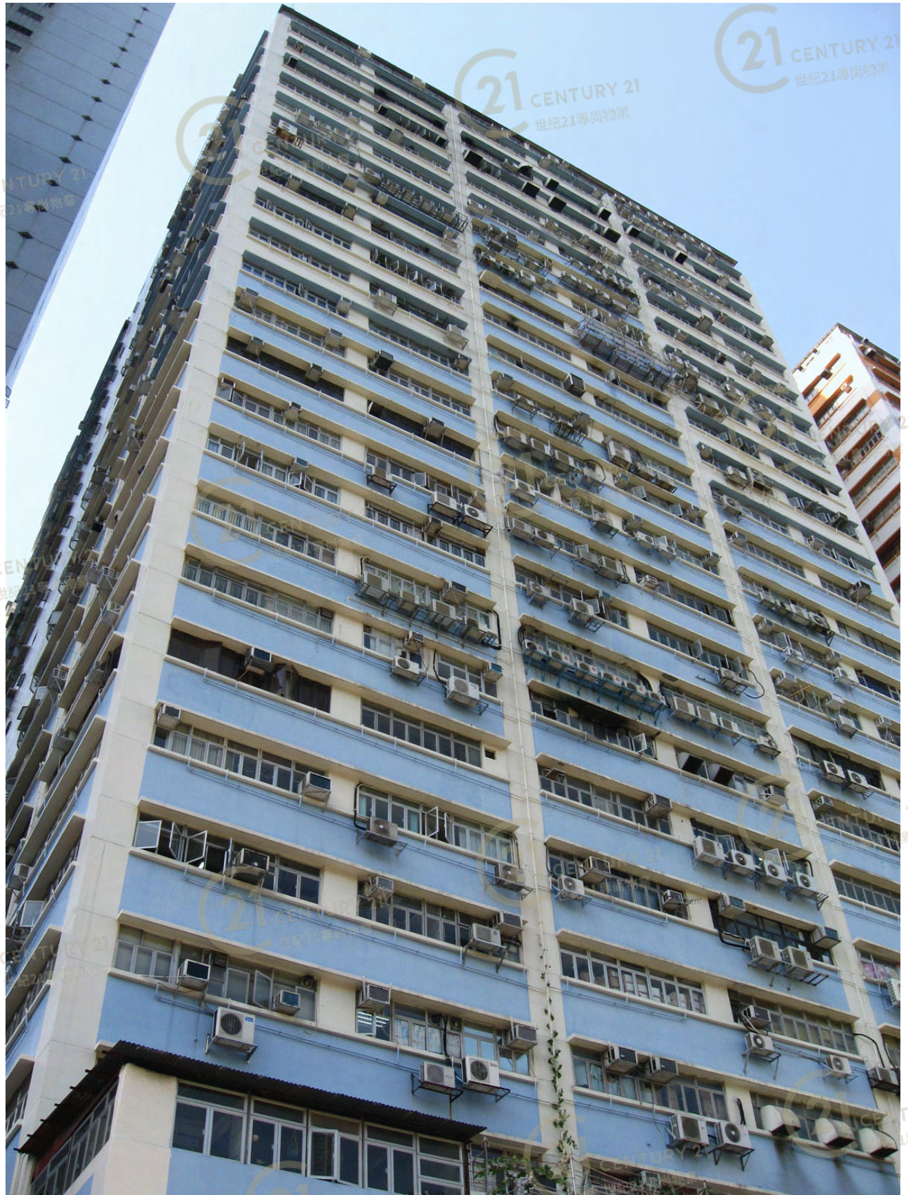
金龍工業中心4座 Golden Dragon Industrial Centre Block 4
