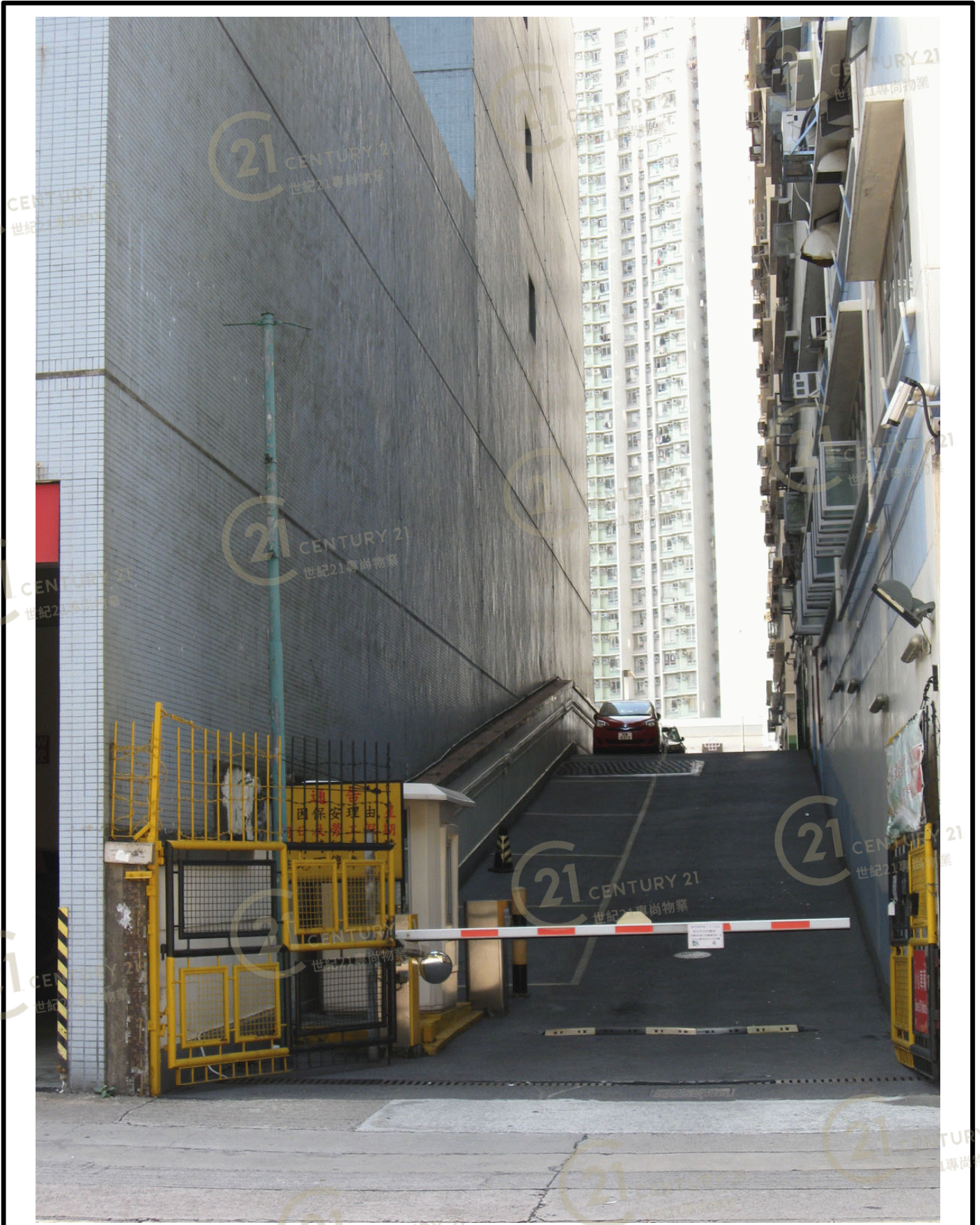
金龍工業中心4座 Golden Dragon Industrial Centre Block 4
