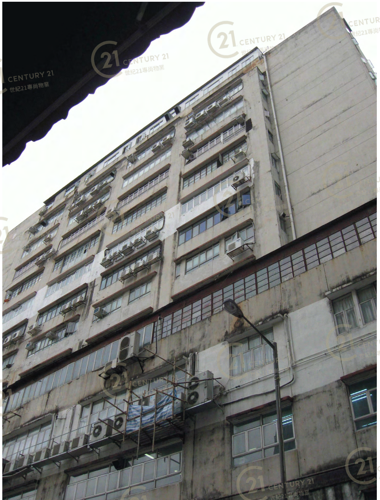
榮森第二工業大廈 Wing Sam 2nd Industrial Building
