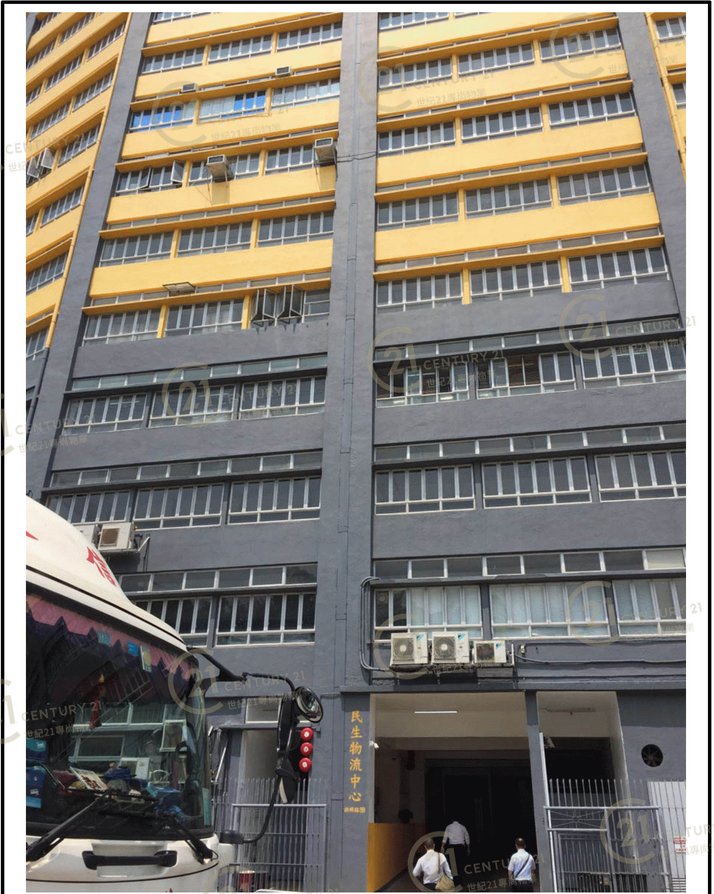
民生物流中心 Man Sun Logistics Centre
