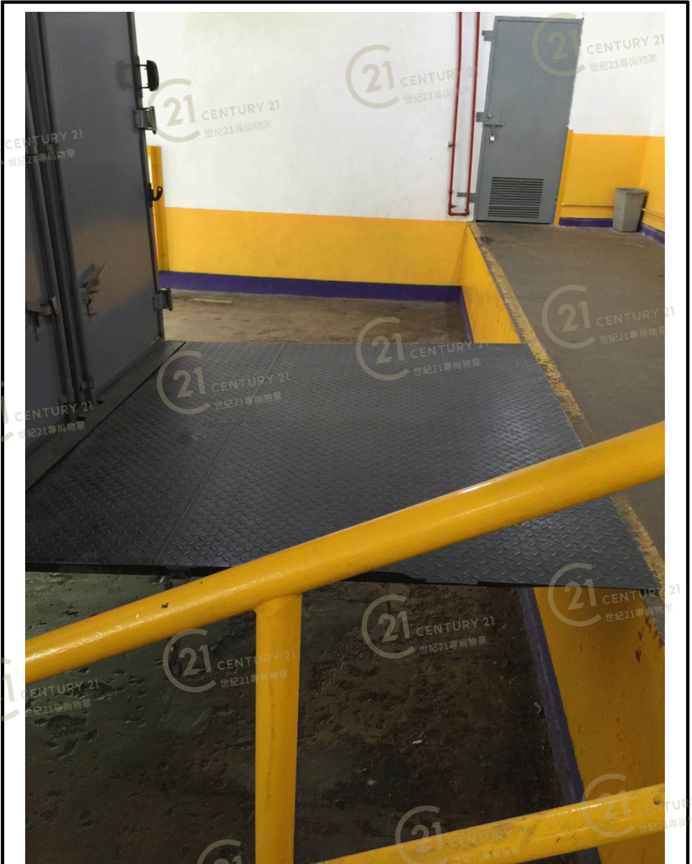
民生物流中心 Man Sun Logistics Centre
