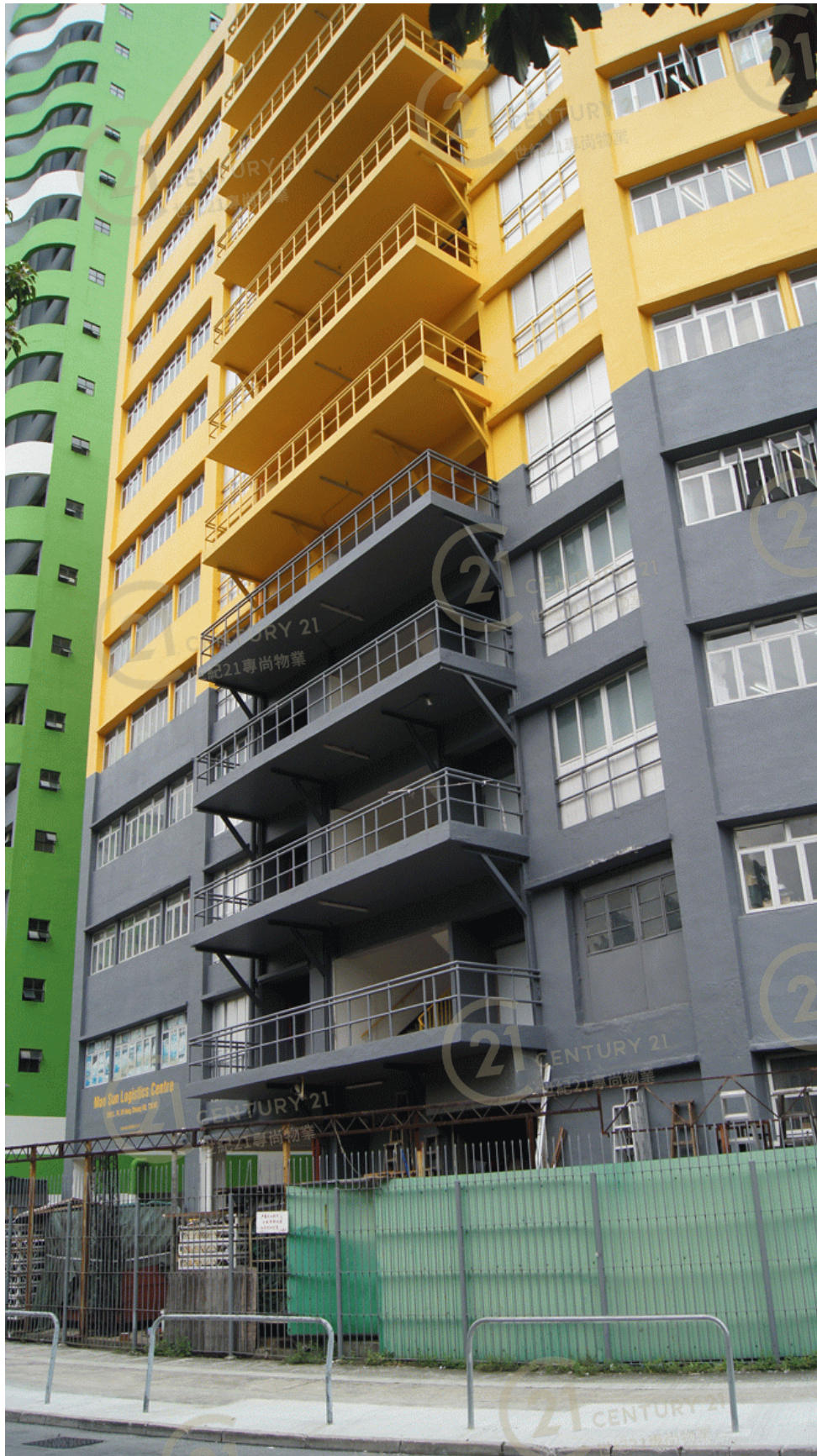
民生物流中心 Man Sun Logistics Centre
