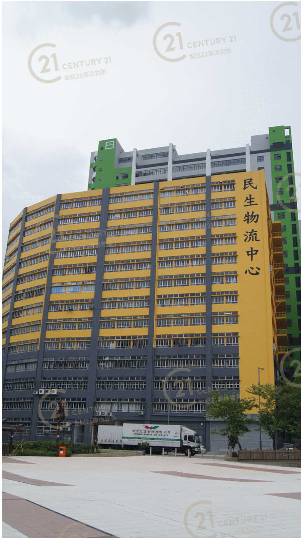
民生物流中心 Man Sun Logistics Centre
