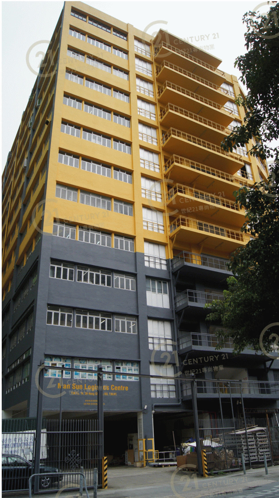
民生物流中心 Man Sun Logistics Centre
