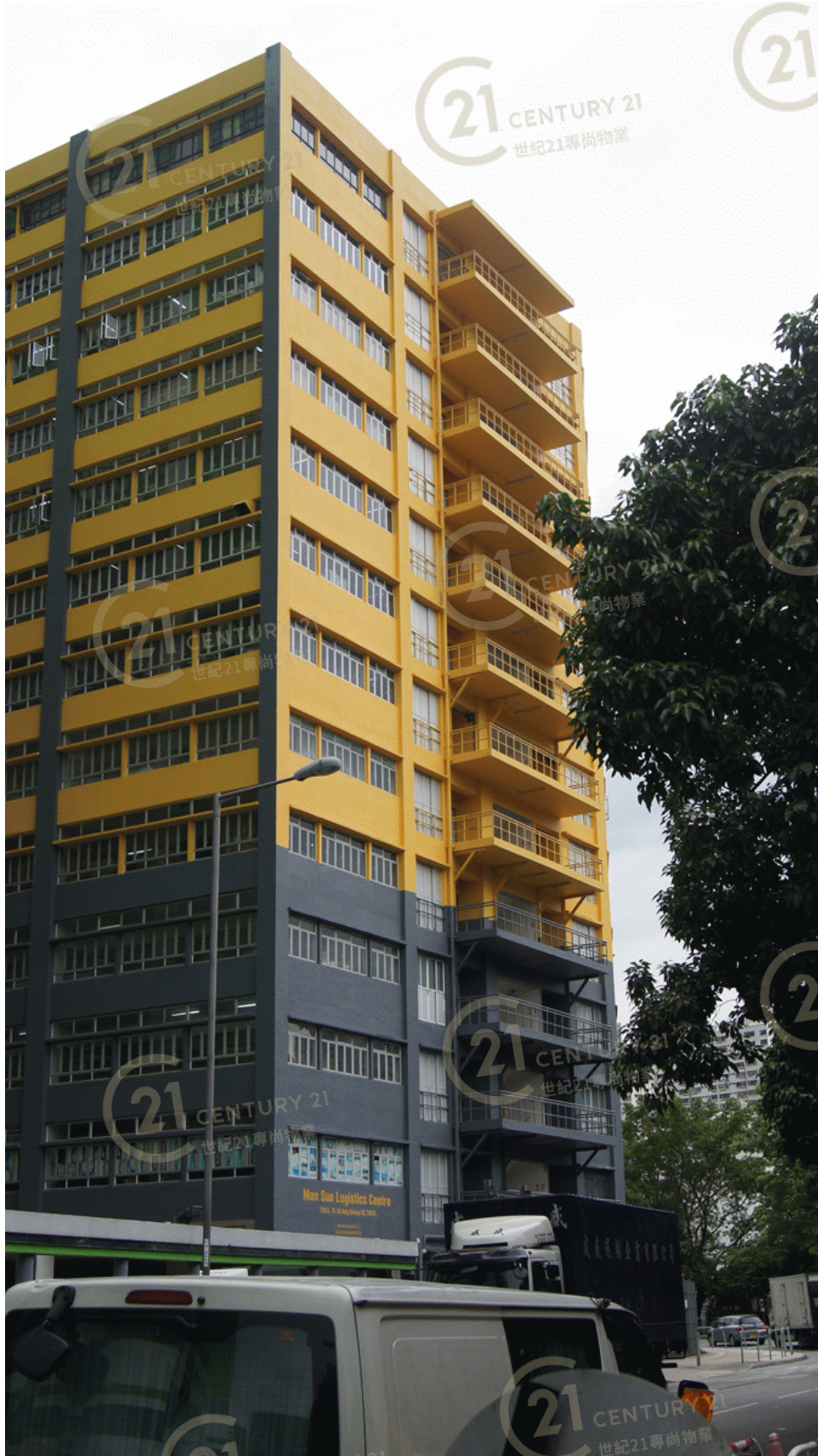
民生物流中心 Man Sun Logistics Centre
