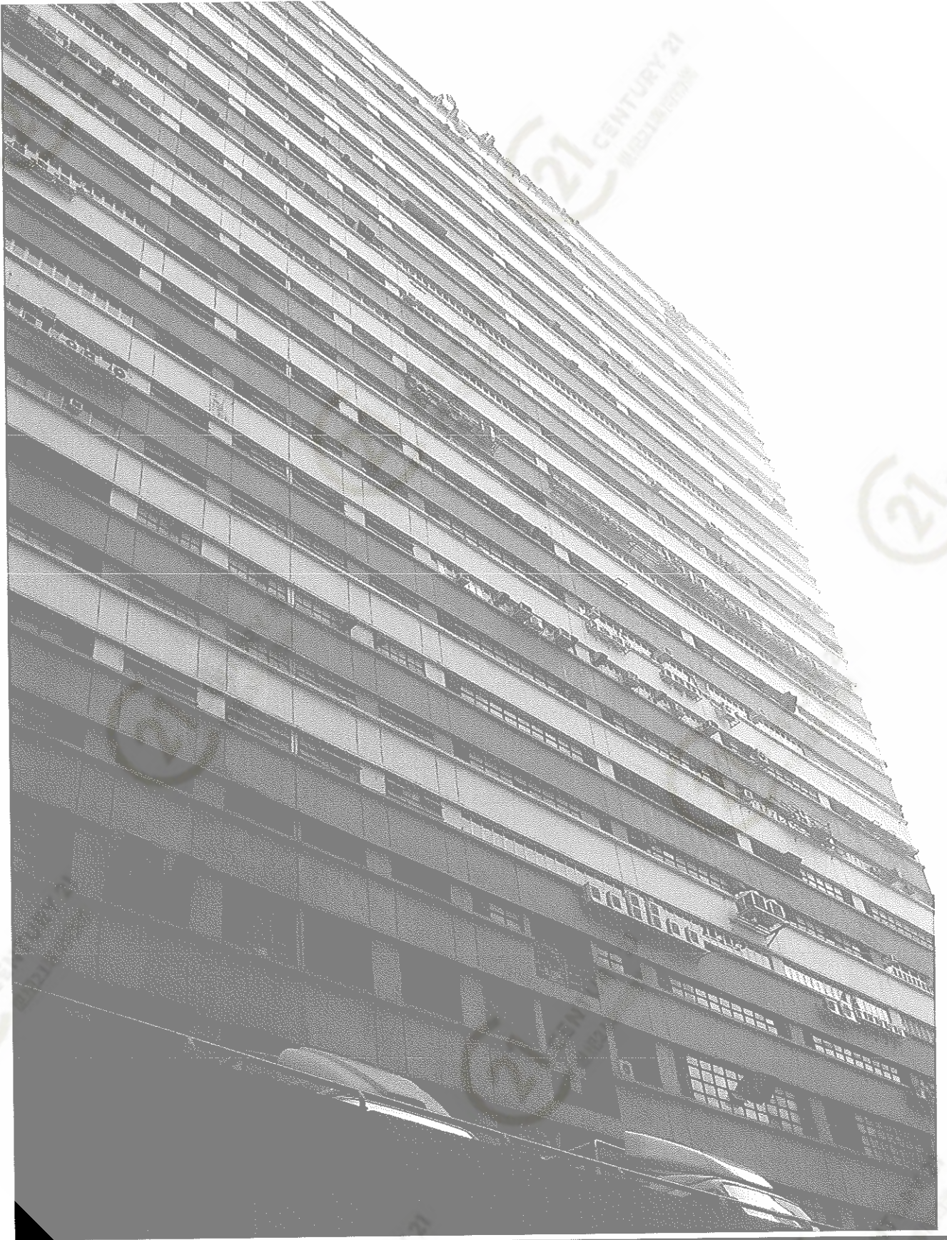
荃灣工業中心 Tsuen Wan Industrial Centre
