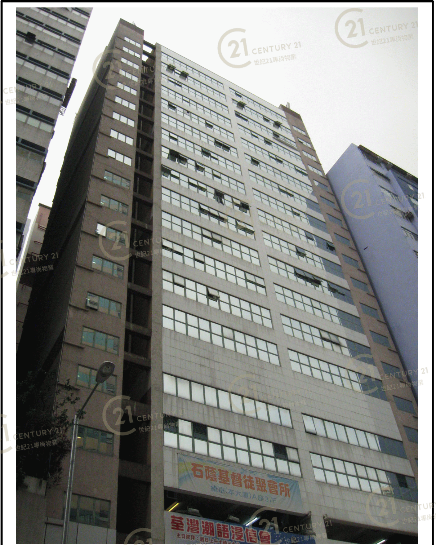
維京科技商業中心A座 Viking Technology & Business Centre A
