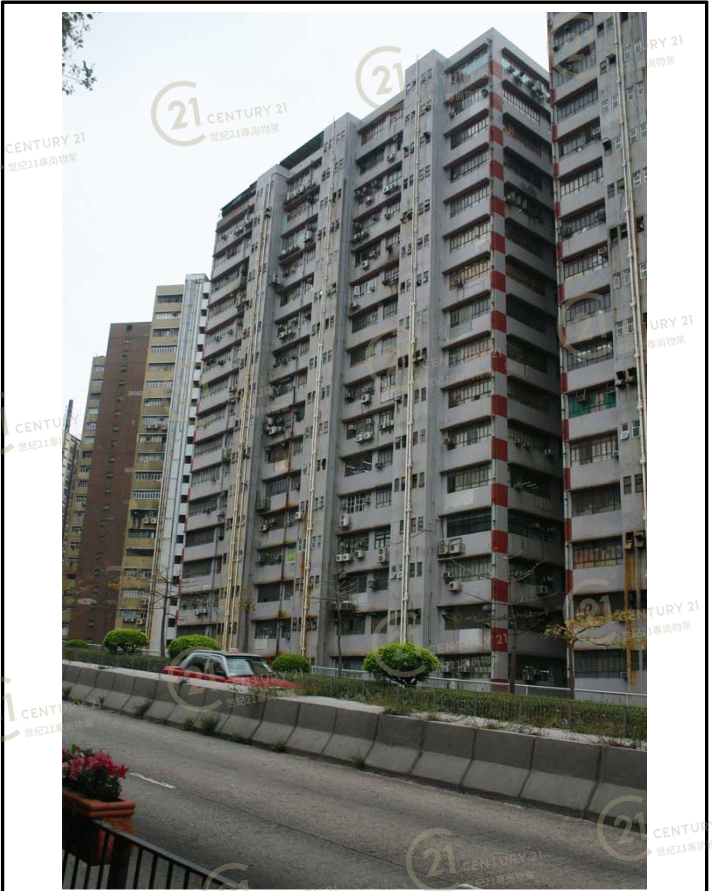
華達工業中心C座 Wah Tat Industrial Centre Block C
