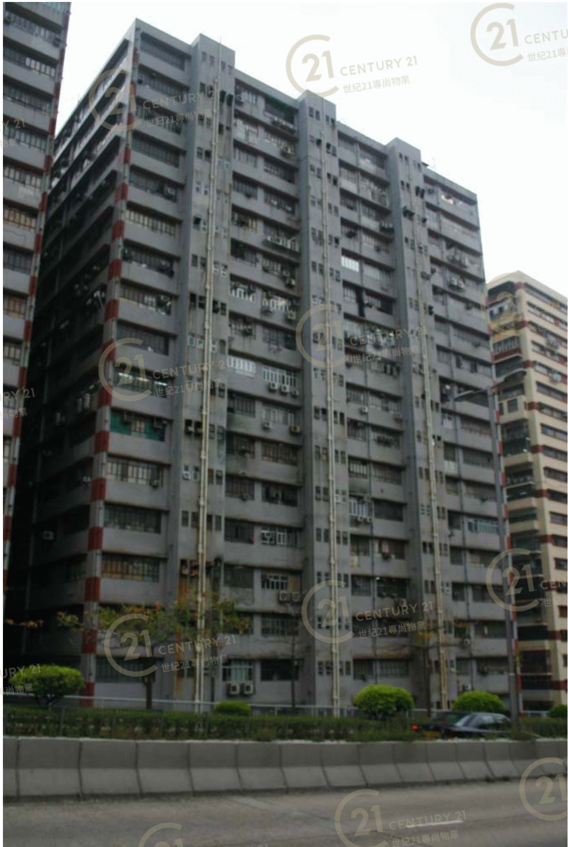
華達工業中心C座 Wah Tat Industrial Centre Block C
