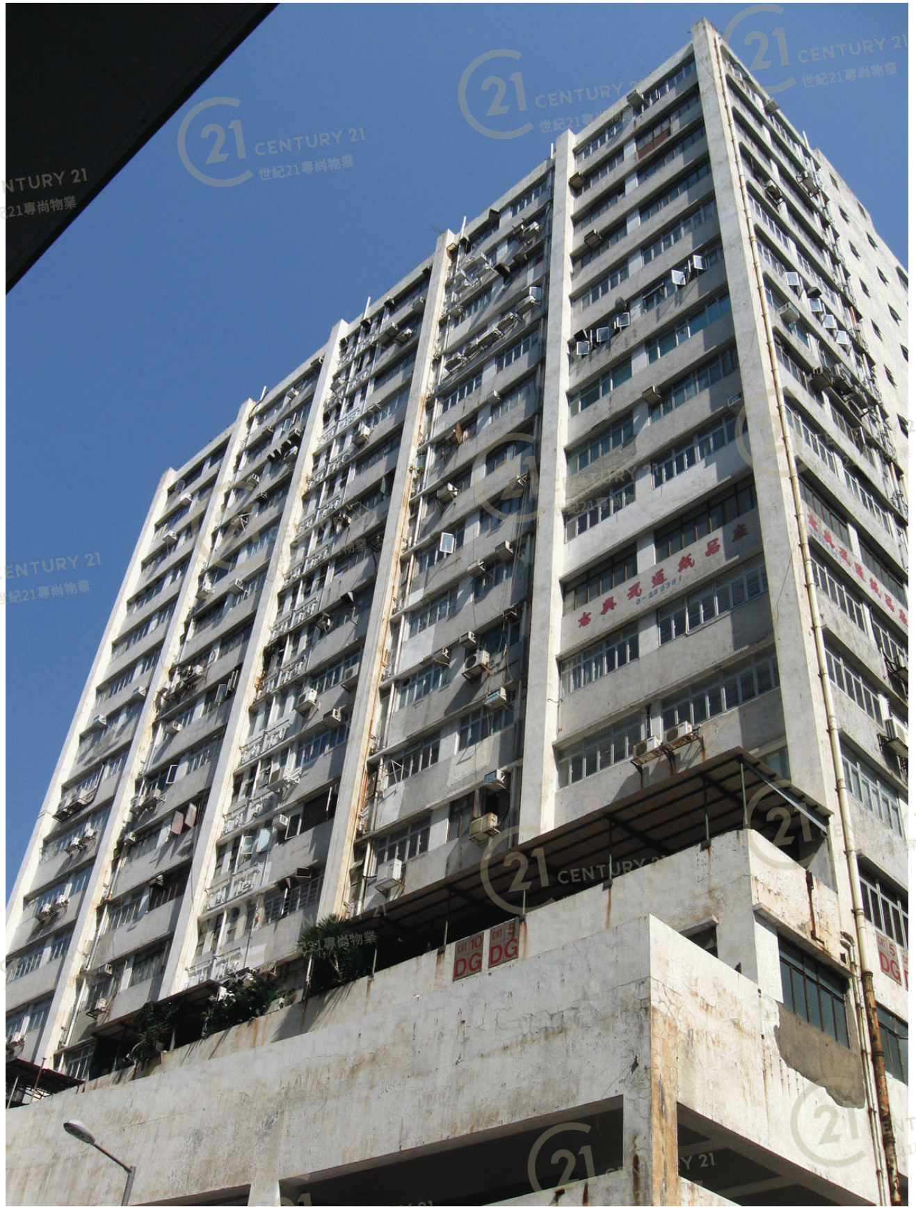
高威工業中心A座 Gold Way Industrial Centre Block A
