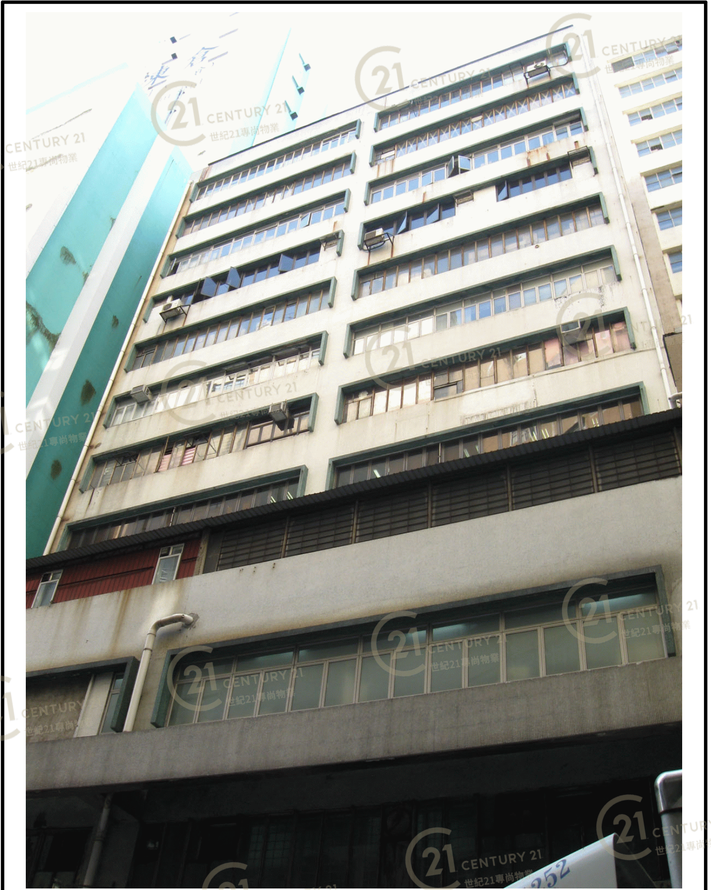
華福工業大廈 Waford Industrial Building
