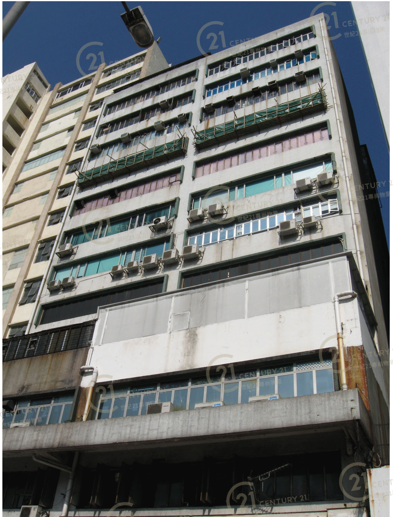
華福工業大廈 Waford Industrial Building
