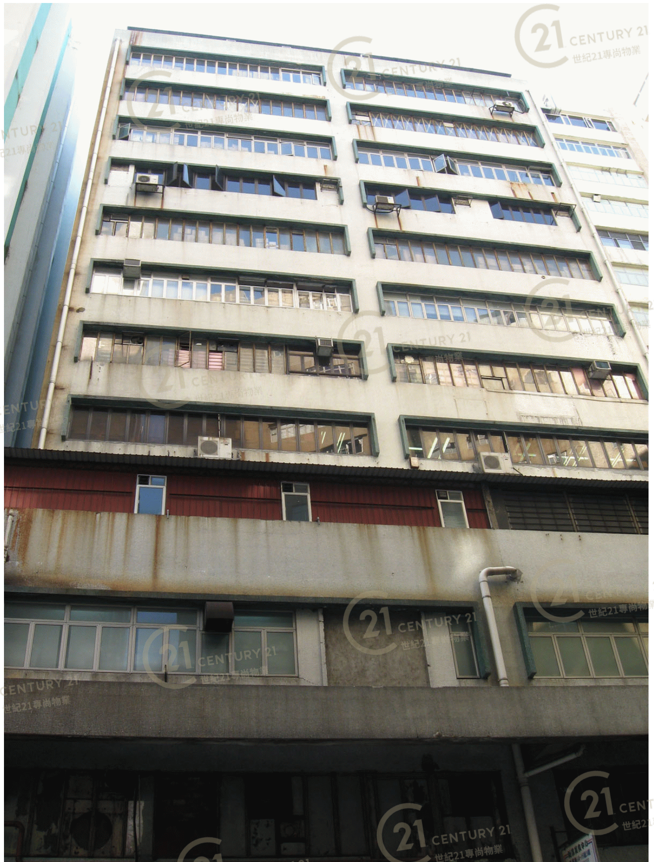
華福工業大廈 Waford Industrial Building
