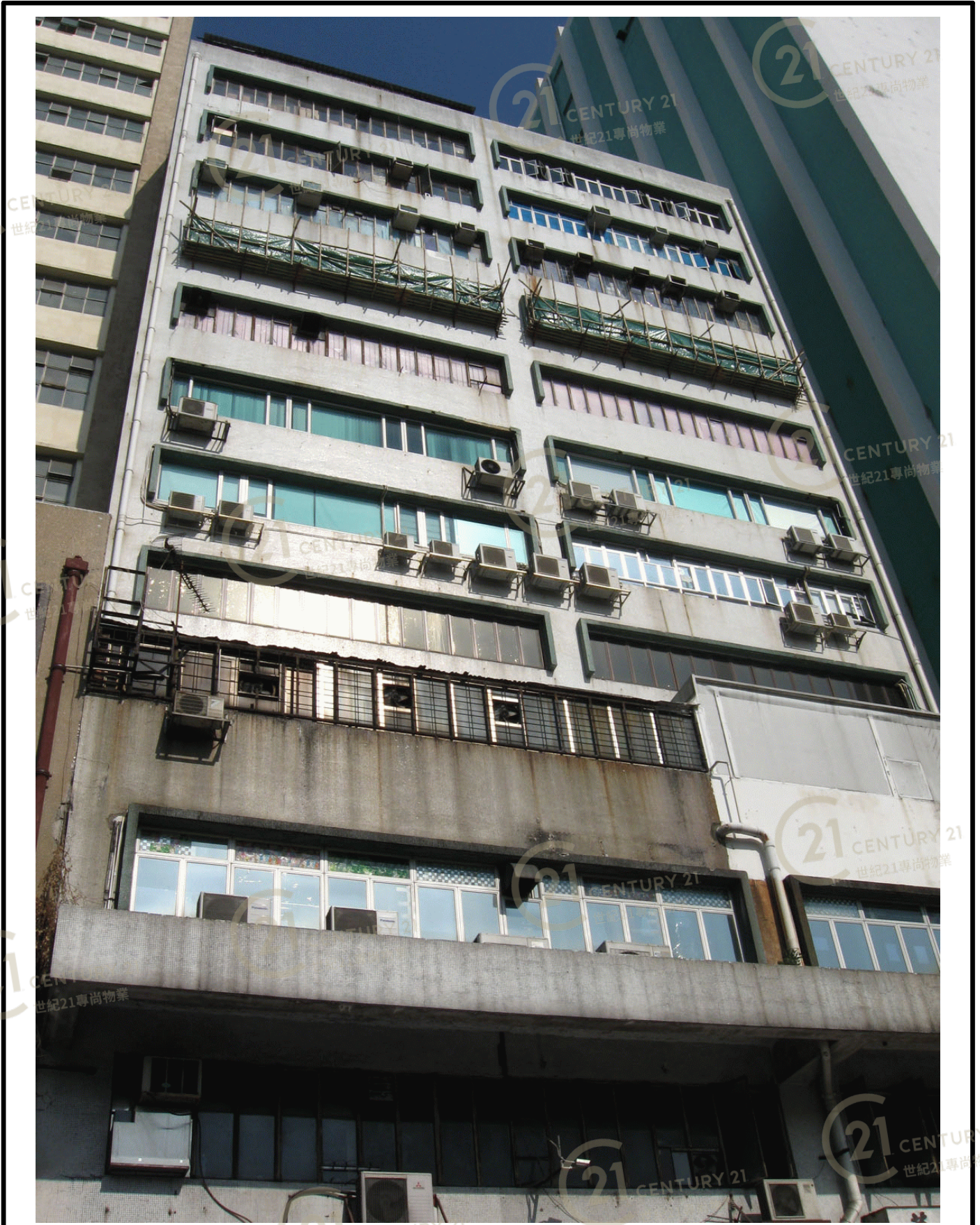
華福工業大廈 Waford Industrial Building
