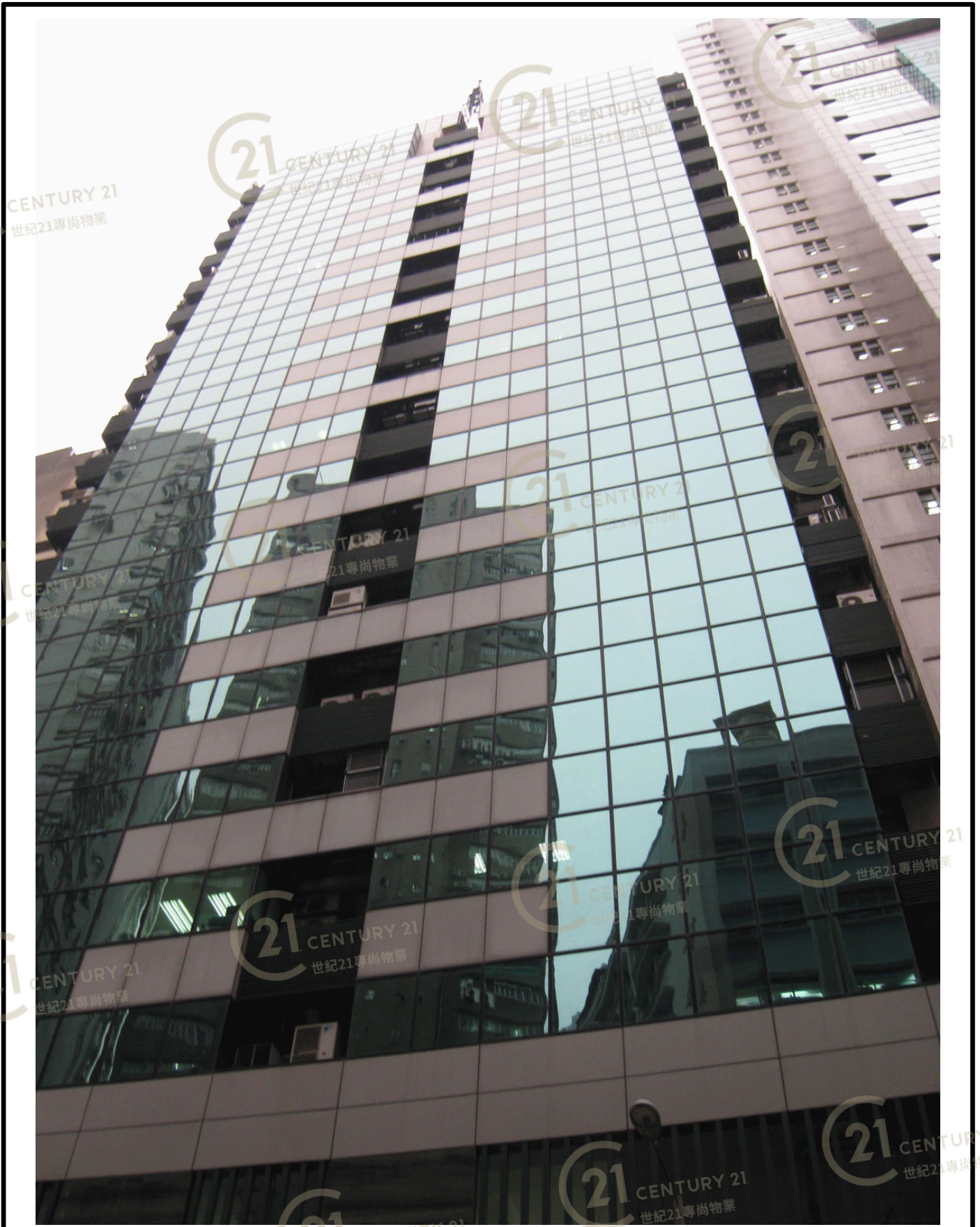
海暉中心 Seapower Centre
