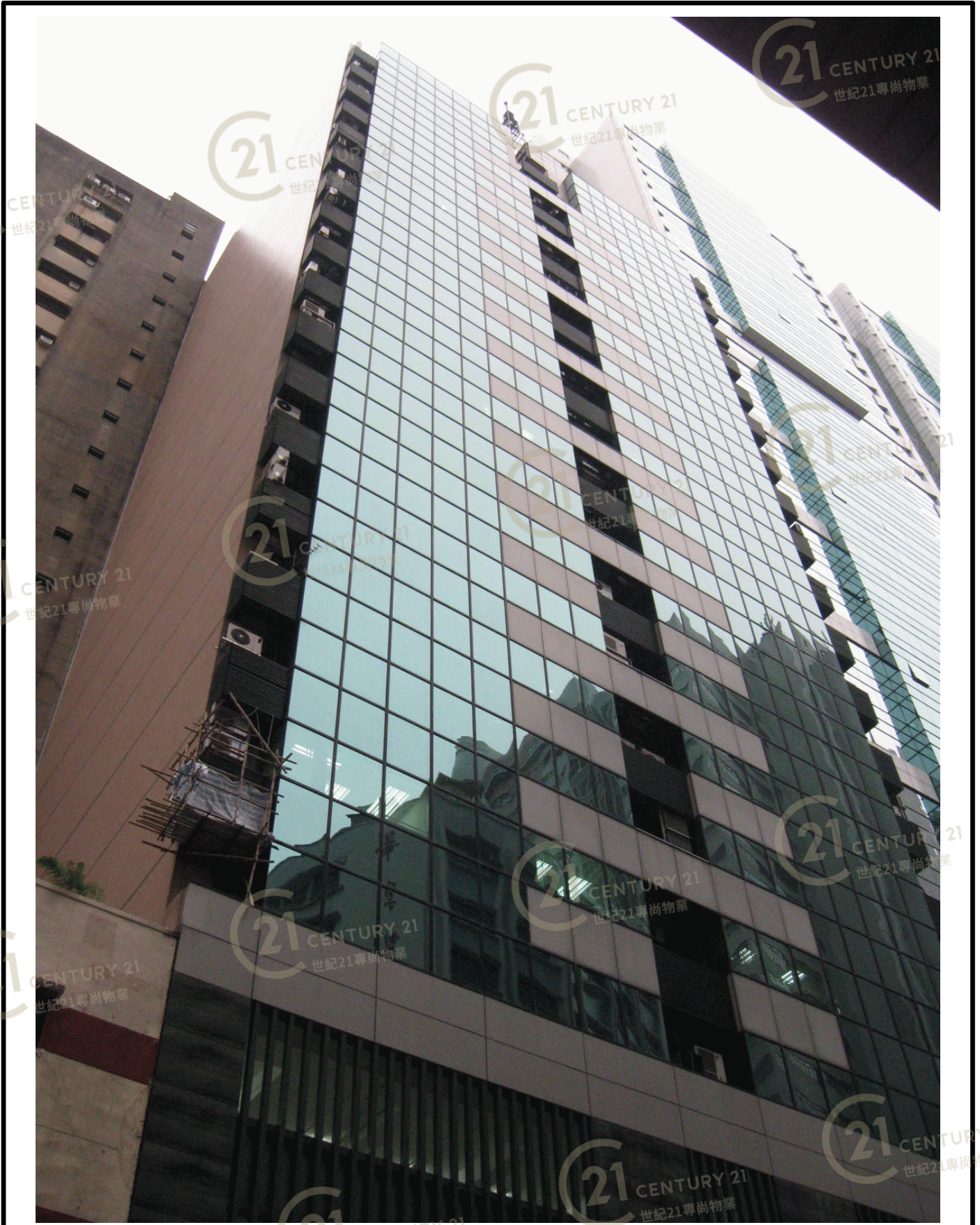
海暉中心 Seapower Centre
