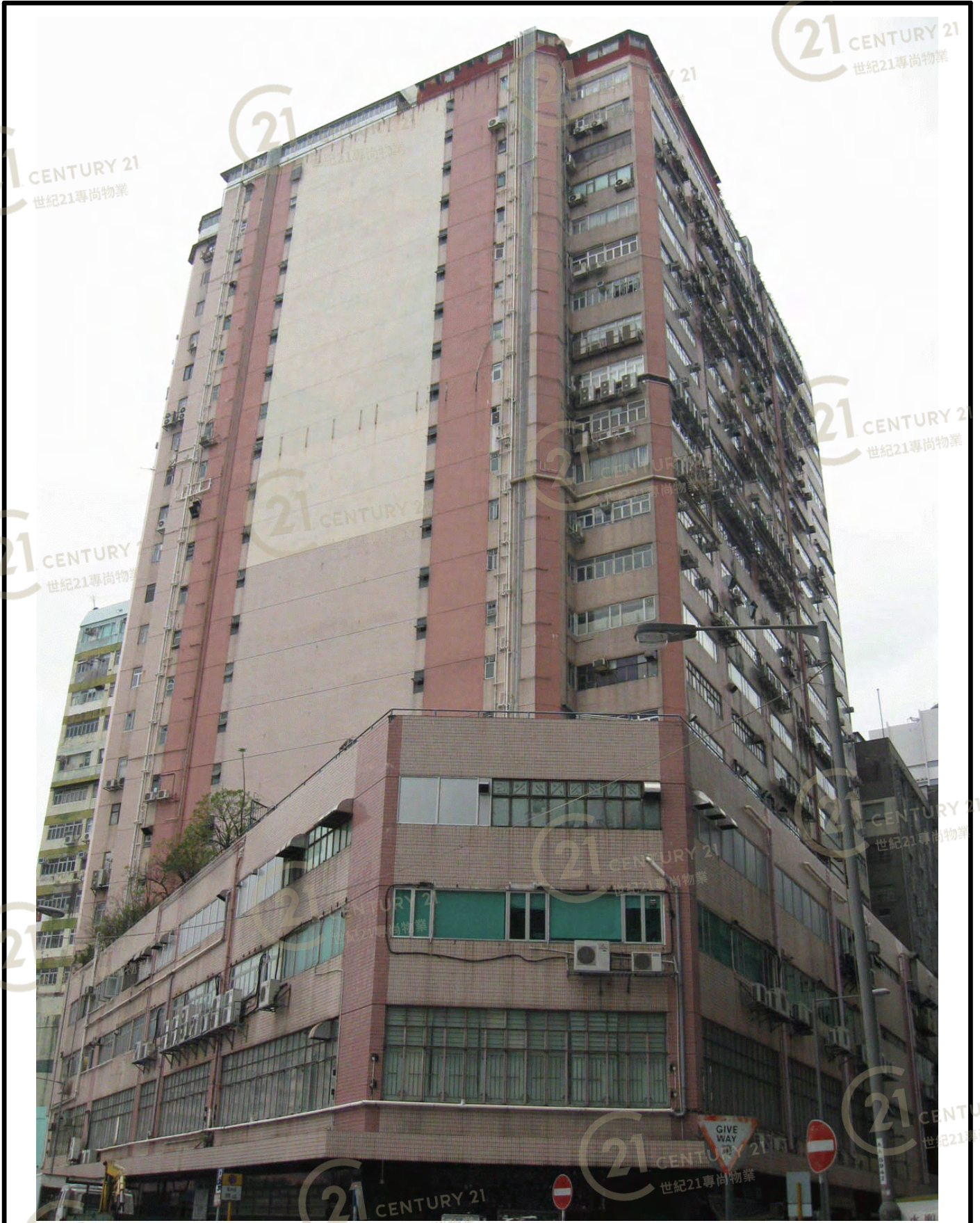
六合工業大廈 Luk Hop Industrial Building
