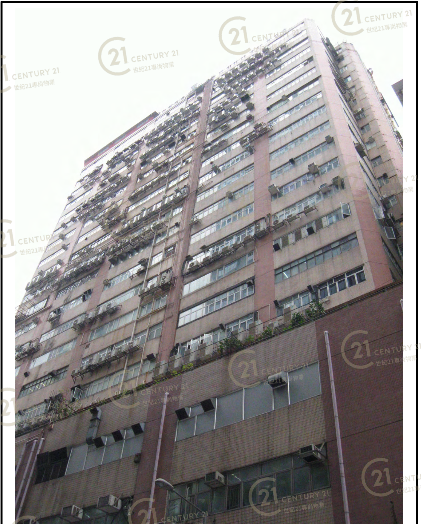
六合工業大廈 Luk Hop Industrial Building
