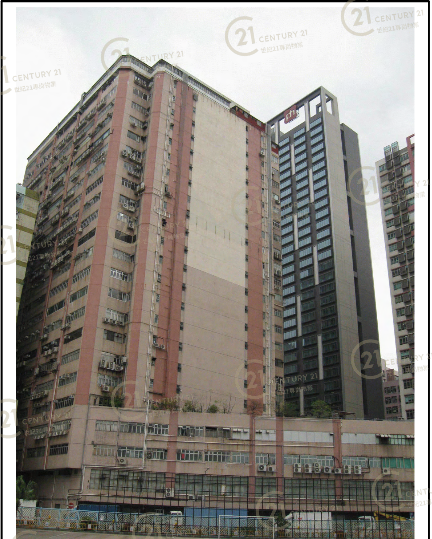
六合工業大廈 Luk Hop Industrial Building
