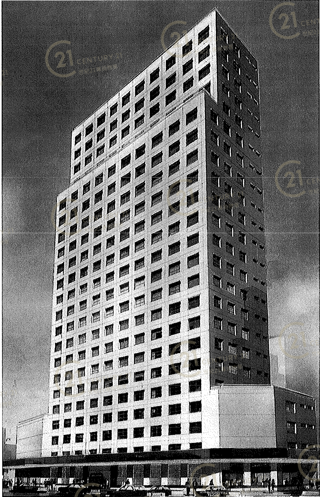
富利工業大廈 Richwealth Industrial Building
